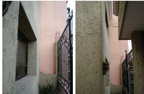
Figura 14. Detalle de ventana
