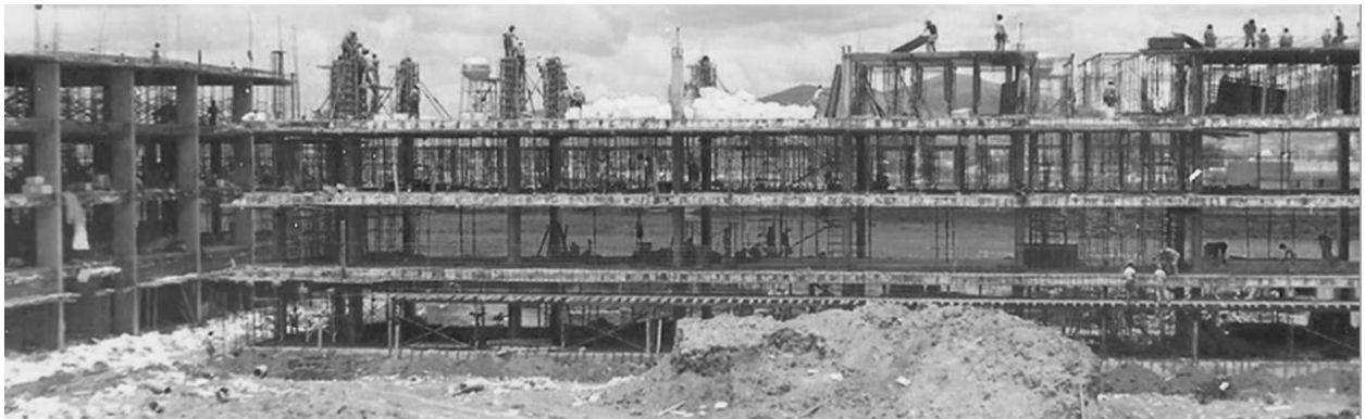
Figura 2.13: Construcción de los edificios G y E en 1974, Tomado del archivo fotográfico (Repositorio Institucional Zaloamati [RIZ], 2019).
