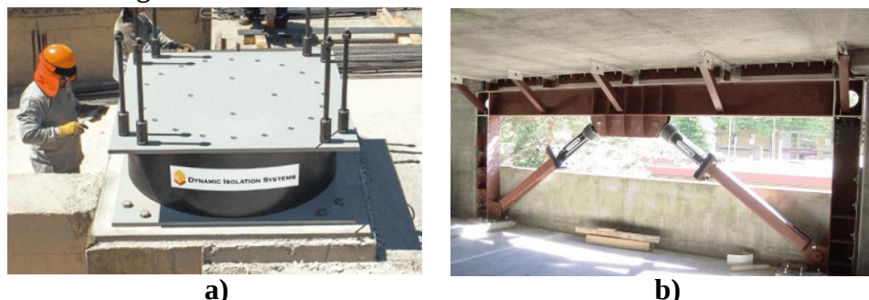
Figura 3.2: Sistema de control: a) aislador sísmico y b) disipadores de energía sísmica, (extraído en www.cdvperu.com , 2022).
