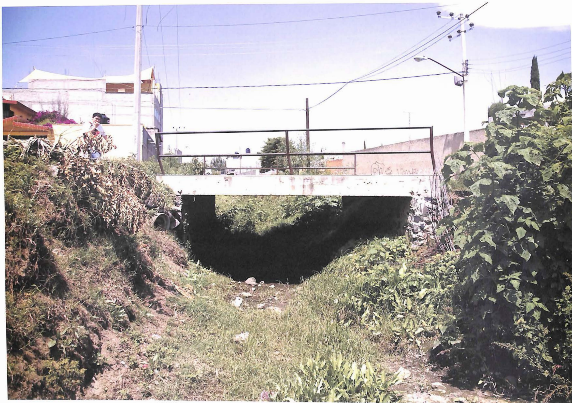
3. Cauce en época de estiaje, entrada sur de Villa Milpa Alta (DC).
