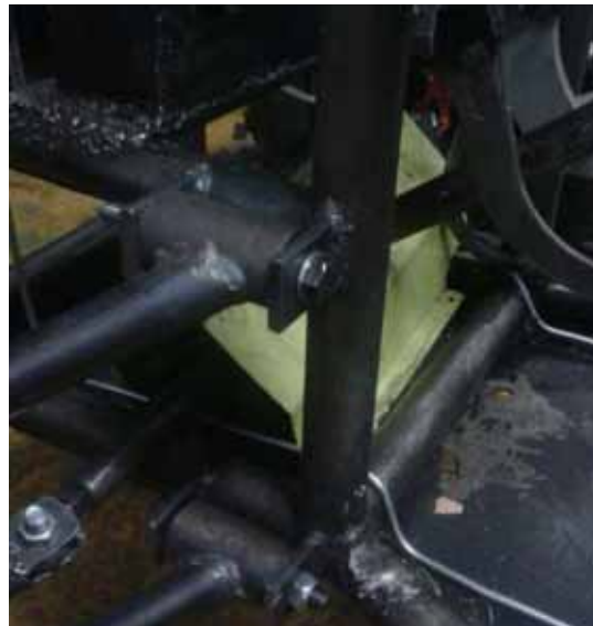
Figura 54. Cubierta construida para la caja de dirección
