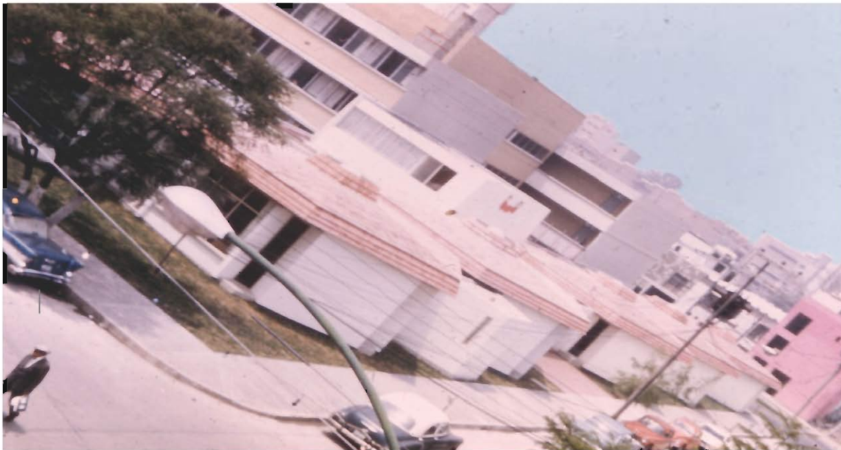
Vista desde la esquina de Uxmal y Repùblicas
