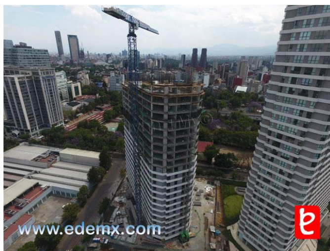
Figura 1.8 Torre Be Grand alto Polanco durante su construcción. Fuente https://www.edemx.com/site/be-grand-alto-polanco-torre-ii/
