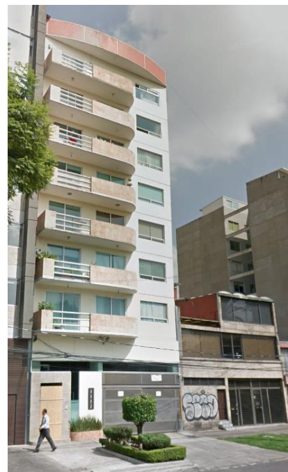
Figura 1.11 Edificio de mampostería confinada de 8 niveles Av. Cuauhtémoc 1117. Alcantaría, Benito Juárez, Ciudad de México. Reportado por Valenzuela (2009)
