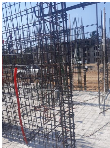
Figura 1.5 Muros de concreto reforzado para vivienda de interés social. Fuente: Ingeniero Aarón Nolasco Hernández, calculista estructural en Consorcio ARA
