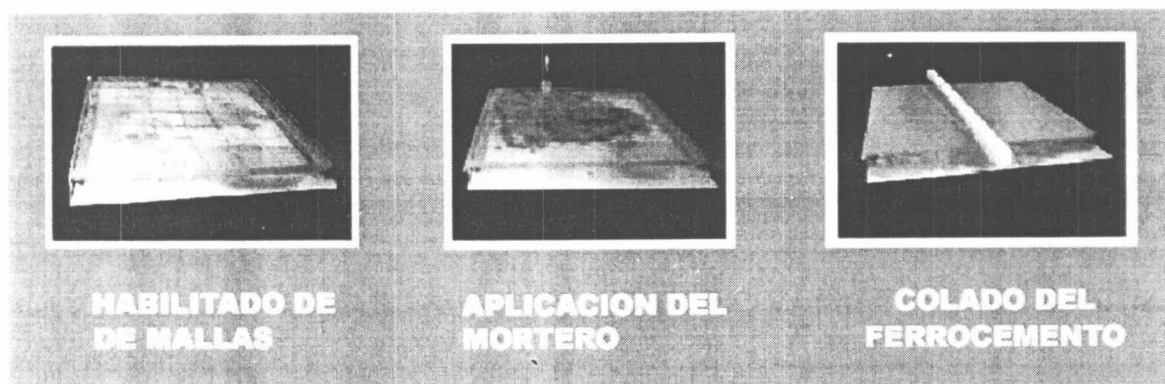
Figura 4.32 Procedimiento constructivo de la placa de ferrocemento
