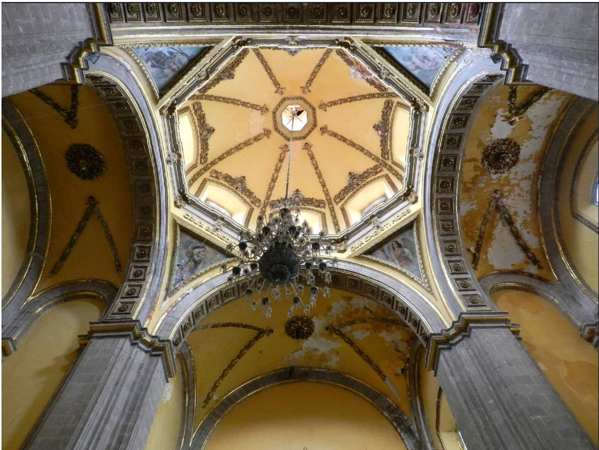
Figura 26. Templo de la Santa Veracruz, Ciudad de México. Vista de la cúpula y crucero, 2013.
