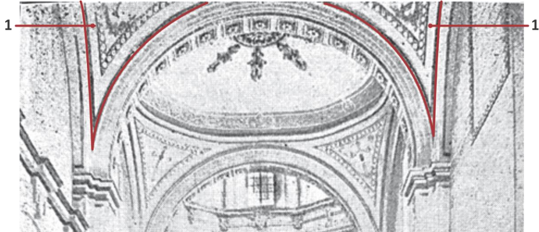
Figura 15. Detalle de dos pechinas de la bóveda cercana al acceso principal.
