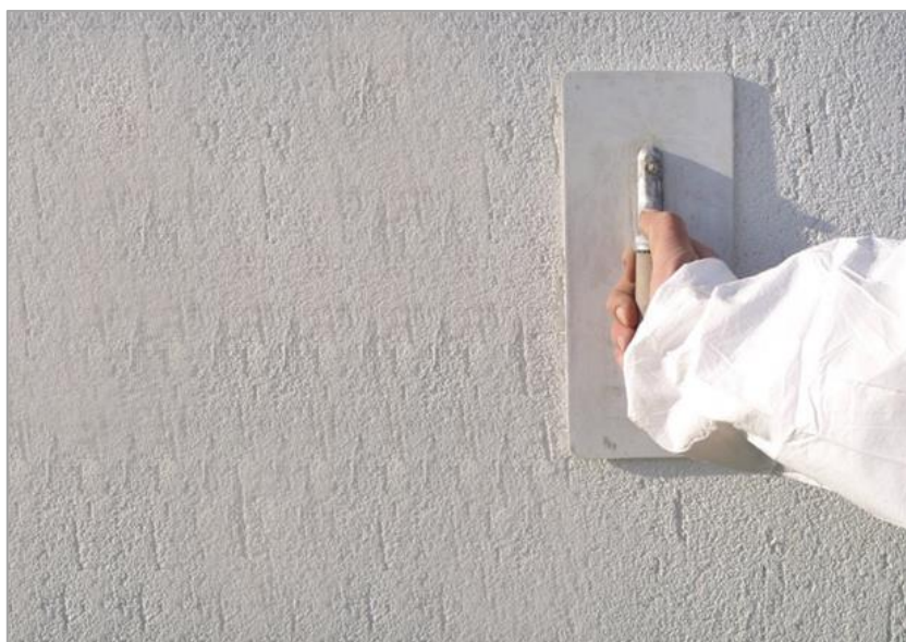
Figura 7. Recubrimiento en muros.
