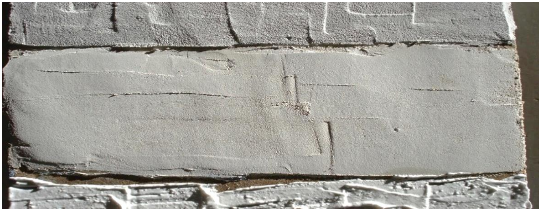
Figura 6. Recubrimientos de muro con distintas mezclas de albañilería.
