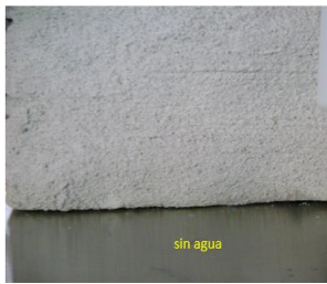
Recubrimiento de cal
