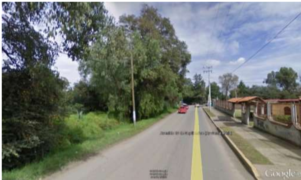
FOTO 14 Y 15 GOOGLE EARTH 2013. FOTO SUPERIOR: AVENIDA 16 DE SEPTIEMBRE HACIA EL SUR Y FOTO INFERIOR, MISMA AV. EL NORTE RESPECTIVAMENTE, SE OBSERVAN CANALES DE RIEGO AL
