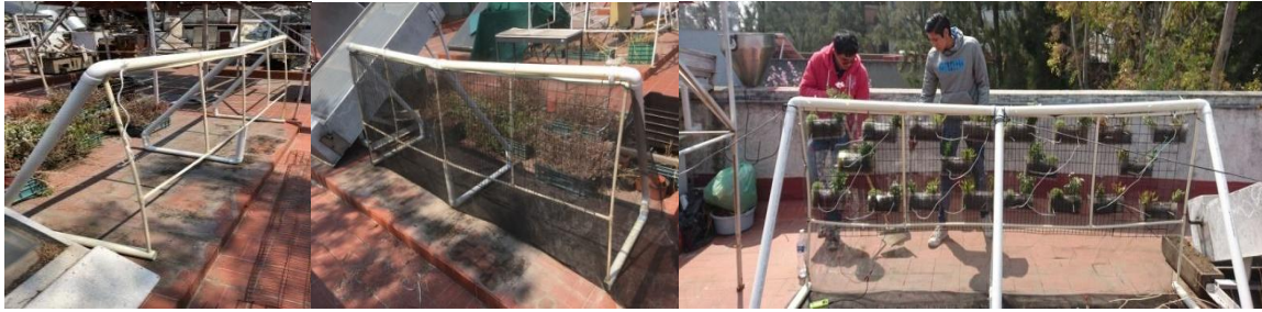
Figura 5. Construcción del Sistema modular.
