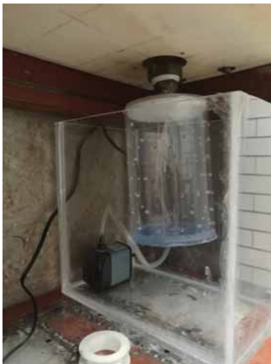
Fotografía 25.- Posicionamiento de la bomba e instalación de manguera flexible.
