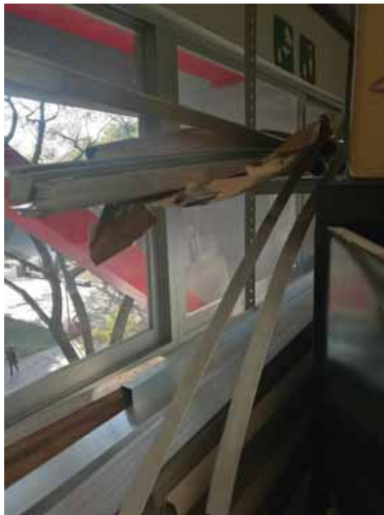
Fotografía 34.- Material solera de aluminio de 1 pulgada para sujeción de forro de lámina en el banco de trabajo.
