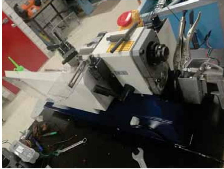
Fotografía 59. Instalación de soporte para servomotor para el sistema de transmisión.
