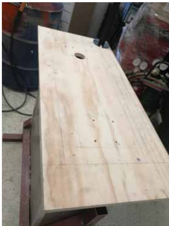
Fotografía 42.- Trazado de la mesa del banco de trabajo, para proceso de barrenos y colocación del torno.
