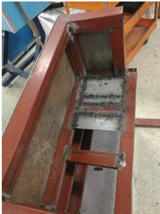
Fotografía 36.- Soldado de lámina de cal. 12 que soportara el depósito de acrílico.
