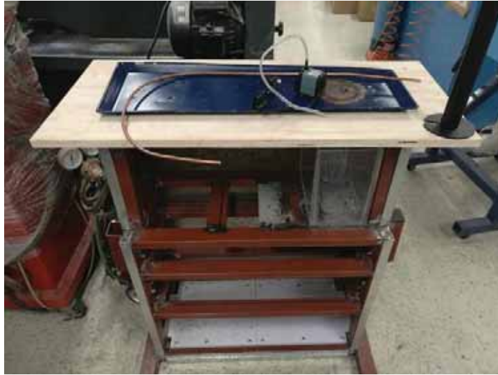
Fotografía 17.- Instalación del depósito, bomba y tubería para el circuito del refrigerante.
