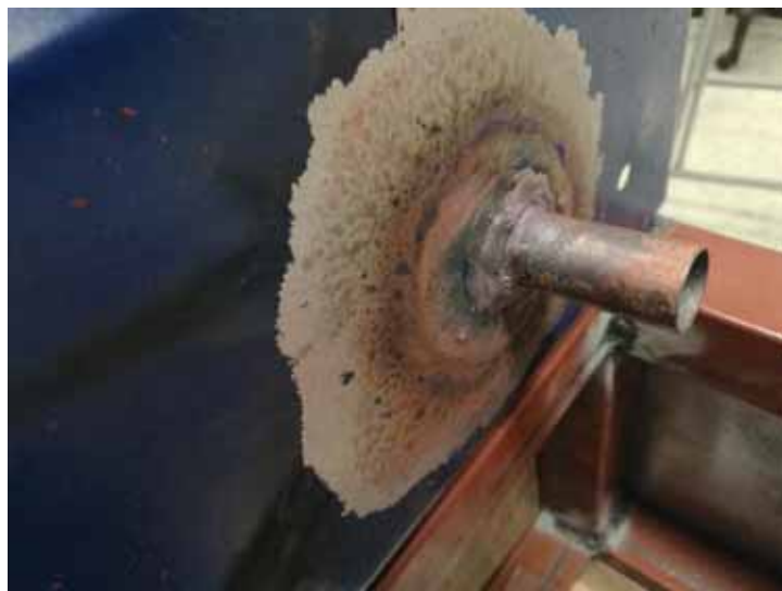
Fotografía 4.- Soldado de tubo de cobre de 3/4" con varilla de plata a la base del torno.
