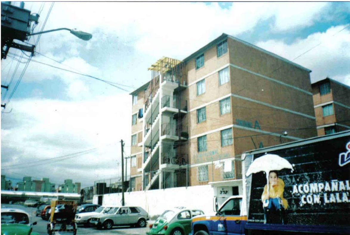
Conjunto Habitacional Carlos A. Madrazo. Construido por desarrolladores inmobiliarios GIG, S.A. de CV. Foto tomada desde la calle 2.
