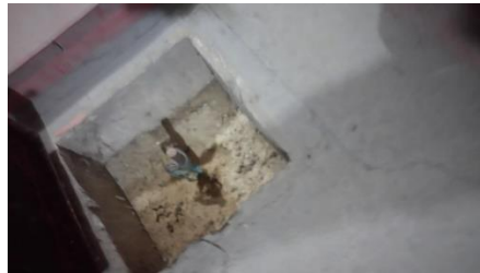
Figura 6.13. Evidencia de tierra física (Fuente: imagen tomada del archivo de levantamiento).
