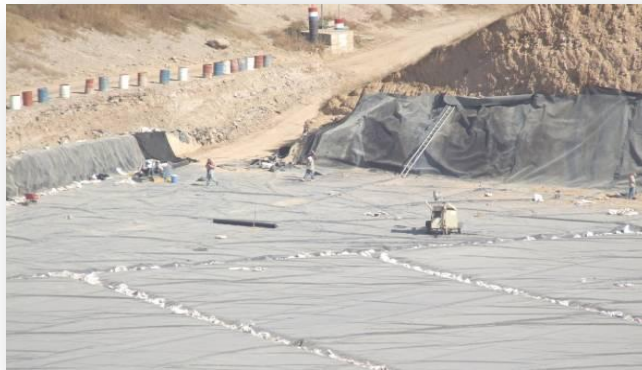
Figura 3.1. Construcción de un relleno sanitario tecnificado.
