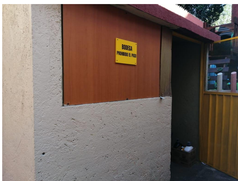
FIGURA 10. Área de acopio de los residuos generados.
