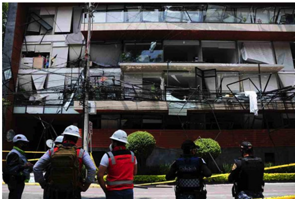
Figura 6. Edificio de Av. Coyoacán: destape del cartel inmobiliario
