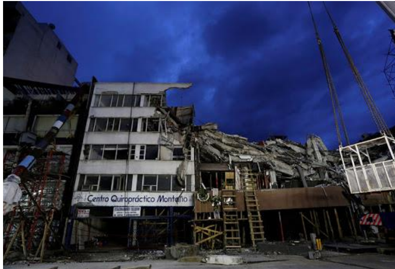
Figura 2.3. Edificios que colapsaron por choque estructural en Álvaro Obregón, Hipódromo Condesa, durante el sismo del 19 de septiembre de 2017 ( http://campechehoy.mx/2017/11/05/haran-memorial-19-s-en-alvaro-obregon-286/ )
