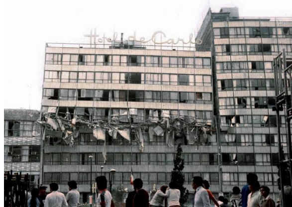
Figura 2.1. Colapso de entrepisos por choque estructural presentado en el Hotel de Carlo durante el sismo de 1985 ( http://danielaguilarfotografo.blogspot.mx/2013/09/asi-comenzo-todo.html )
