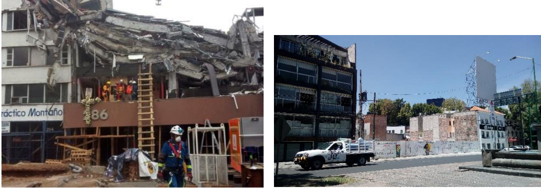
Figura 4.2. Daños ocasionados por choque estructural en Avenida Álvaro Obregón, Hipódromo Condesa, durante el sismo del 19 de septiembre de 2017 y estado de los predios a 2019 ( https://www.nsoaxaca.com/testimonio-de-sobreviviente-de-alvaro-obregon-286-el-edificio-colapso-dos-veces/ )
