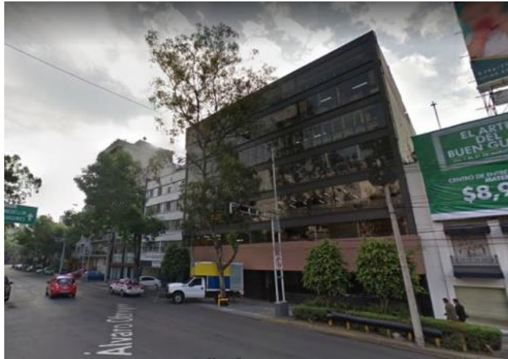
Figura 4.1. Edificio Álvaro Obregón 284 y 286 ubicados en la Colonia Hipódromo Condesa de la Delegación Cuauhtémoc (imagen obtenida de Google maps)
