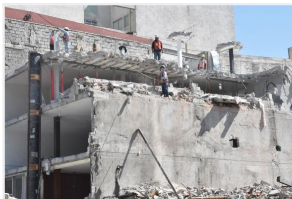
Figura 4.3. Etapa de demolición del edificio Álvaro Obregón 284, ( https://obras.cdmx.gob.mx/comunicacion/nota/finaliza-sobse-demolicion-del-edificio-de-alvaro-obregon-284 )
