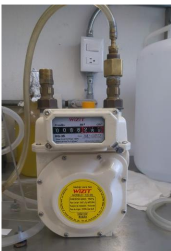
Figura 3. 14 Gasómetro para calibrar el flujo de las bombas y rotámetros.
