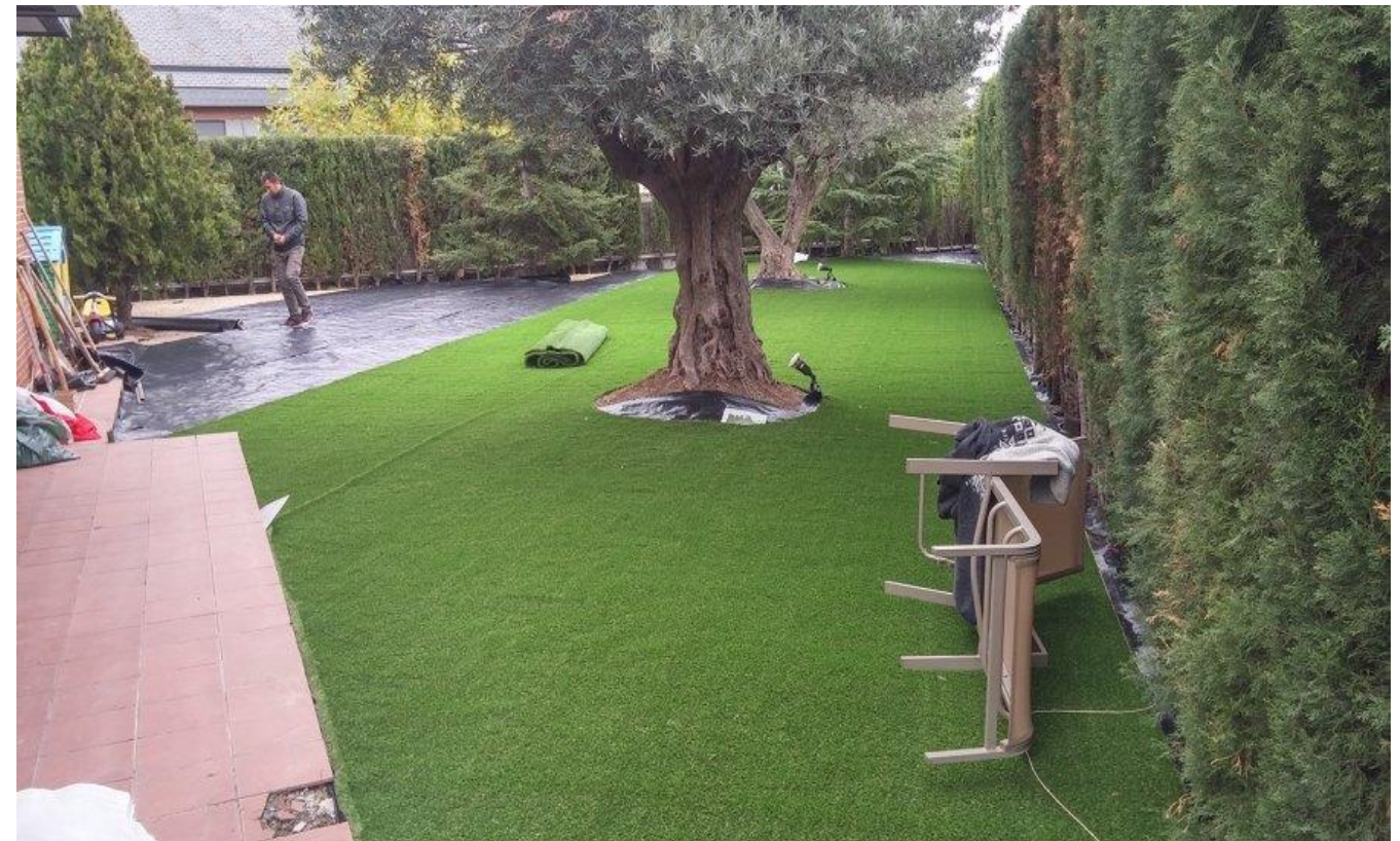
Imagen 19. Habitissimo. España. Instalación de geotextil y césped artificial en Ayulebel. Recuperado de: https://fotos.habitissimo.es/foto/instalacion-geotextil-y-cesped-artificial_1455289
