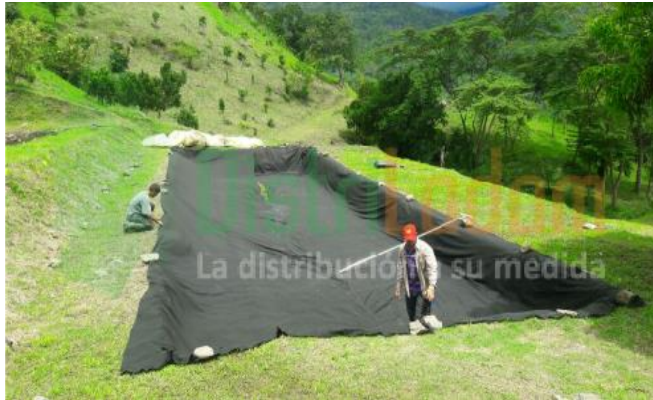
Imagen 20. Distriladam. Procesos de instalación de un geotextil para la adecuación de reservorio de agua. Colombia. Recuperado de: https://www.distriladam.com/procesos-de-instalacion
