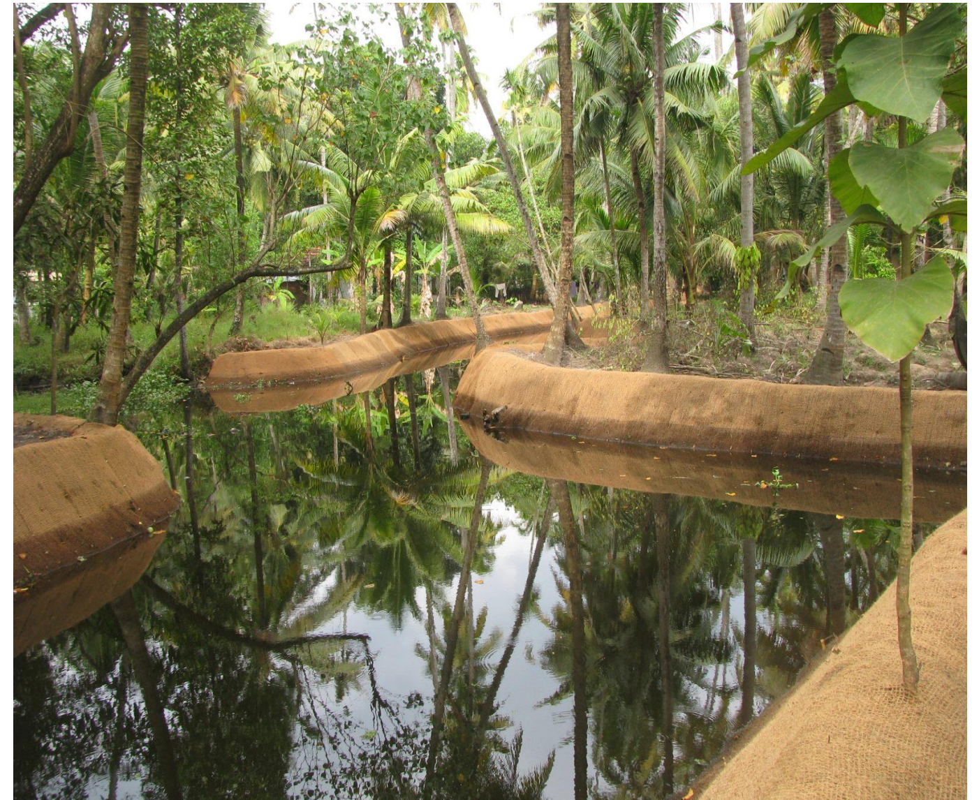
Imagen 22. Coirfed. Geotextil de coco para control de erosión. India Recuperado de: https://coirfed.com/products?category=COIR-GEOTEXTILES
