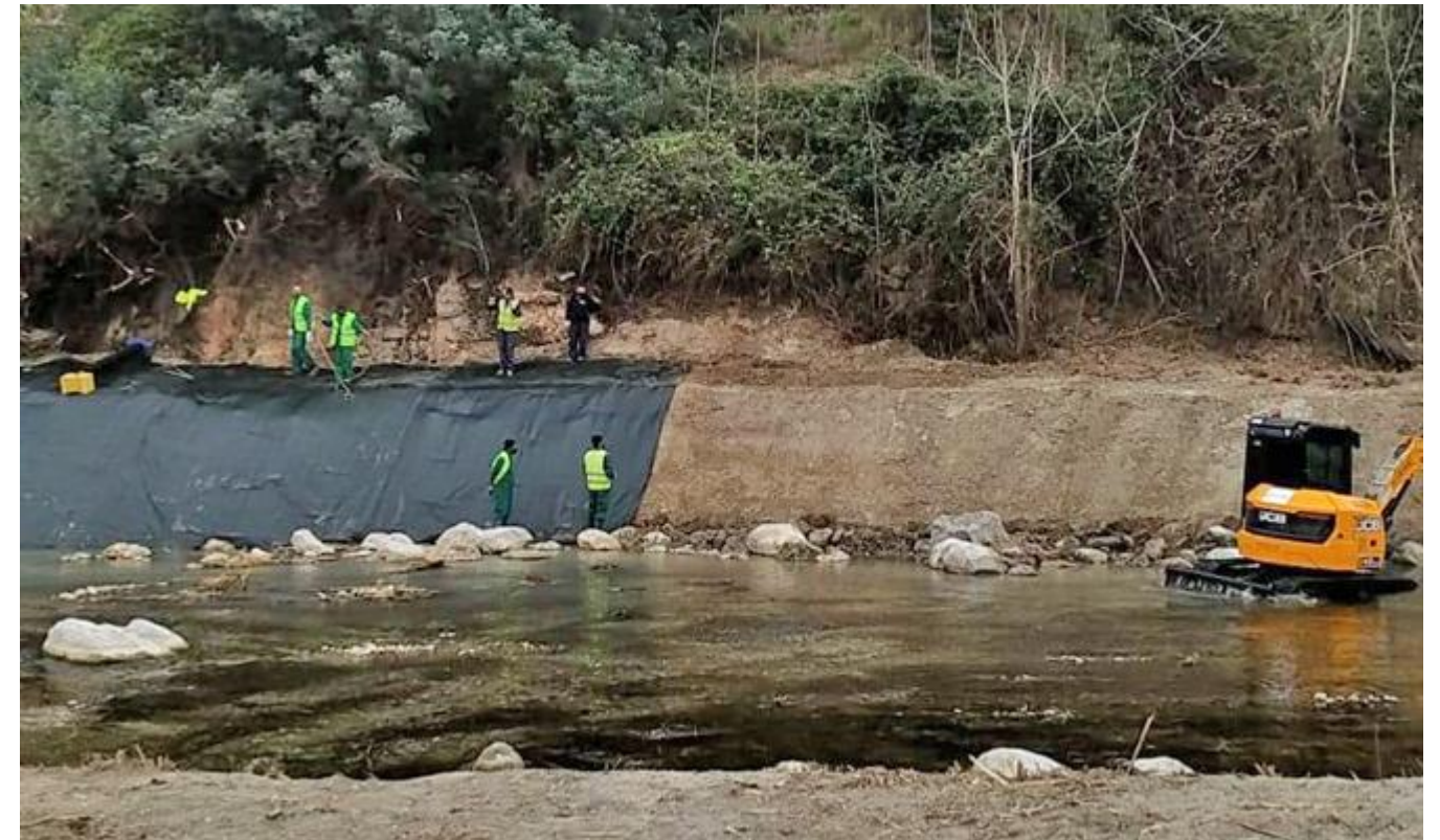
Imagen 21. Saforguia. Instalación de lonas de geotextil. España. Recuperado de: https://saforguia.com/art/60282/la-chj-empieza-a-instalar-lonas-de-geotextil-en-la-actuacion-del-serpis-en-villalonga-contra-las-canas
