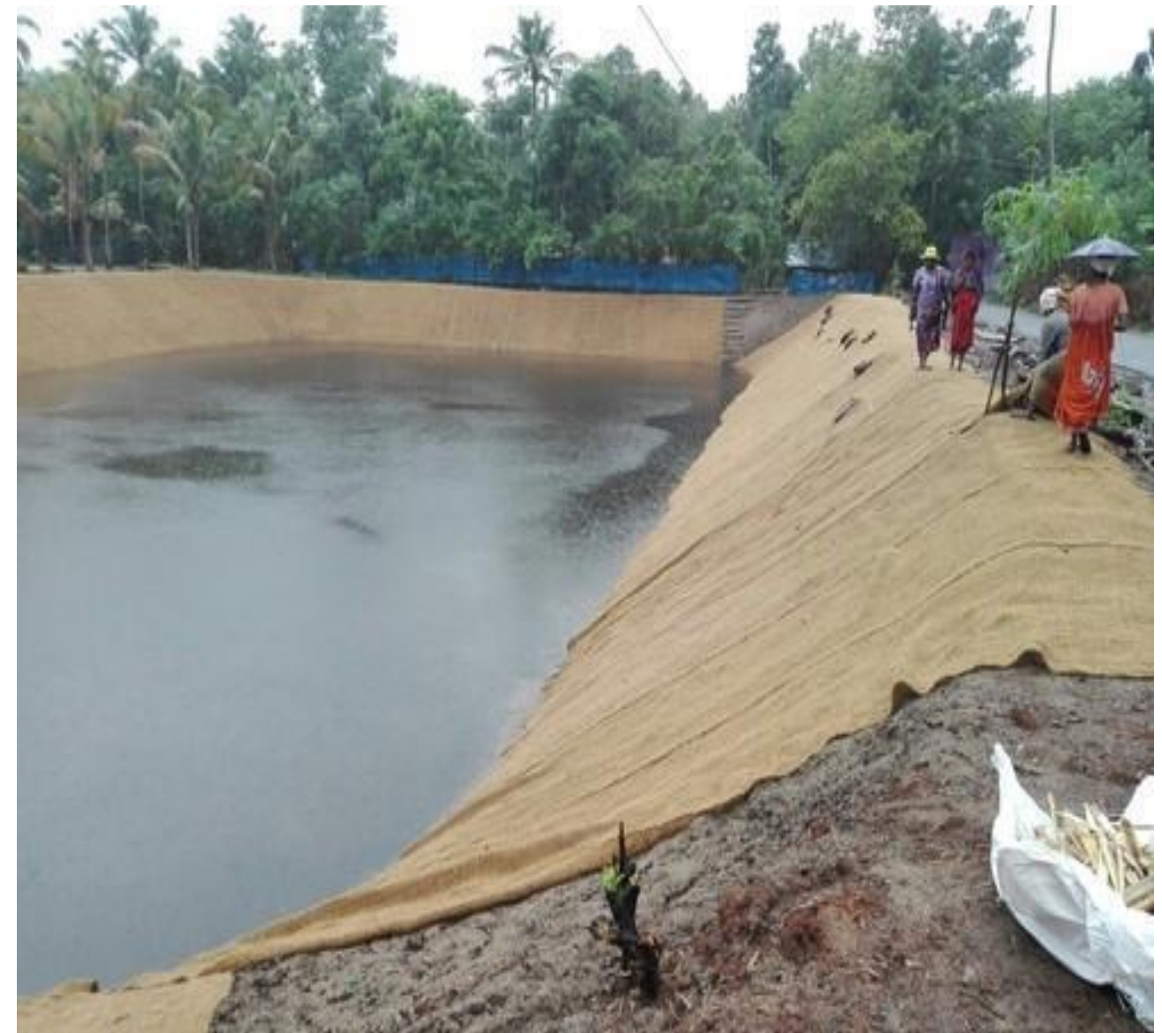
Imagen 25. Dheera Coir Industries. India. Aplicación de Geotextiles para el control de la erosión hídrica en un Estanque. Recuperado de: https://www.indiamart.com/proddetail/coir-geotextiles-matting-erosion-control-15431028091.html .
