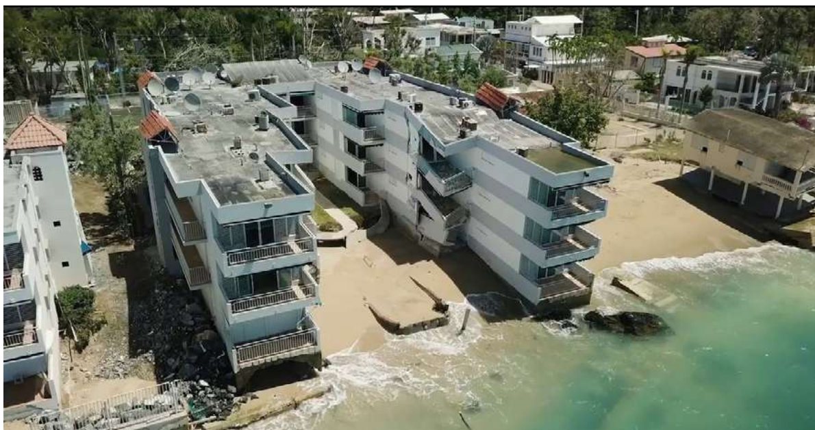
Figura 11. Playa Rincón en Puerto Rico, edificios destruidos por el mar.
