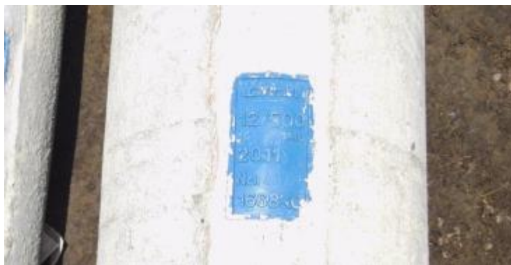
Figura 9. Placa de características en poste [2]
