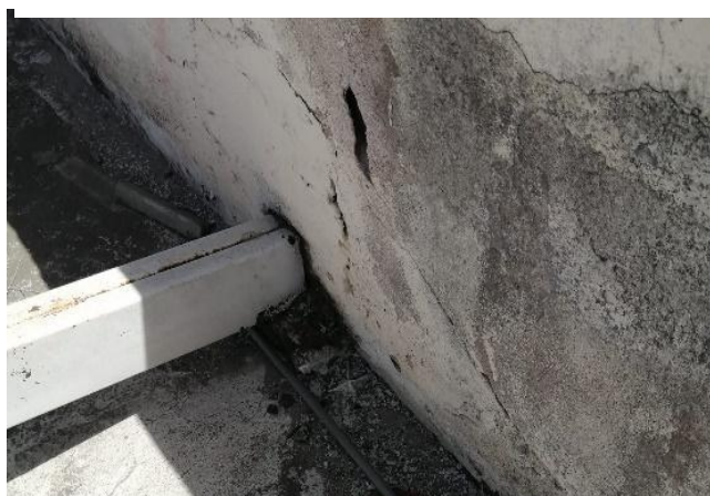
Figura 32. Empotre de estructura a corona de muro.
