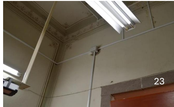
Figura 25. Anclaje de instalaciones en muros.
