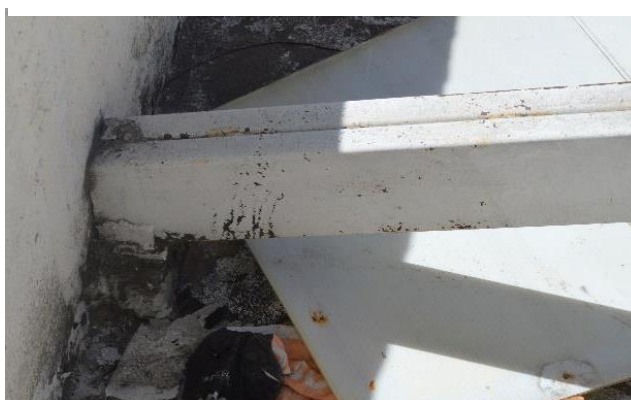
Figura 31. Empotre de estructura a corona de muro.
