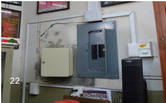
Figura 24. Anclaje de caja de carga en muro
