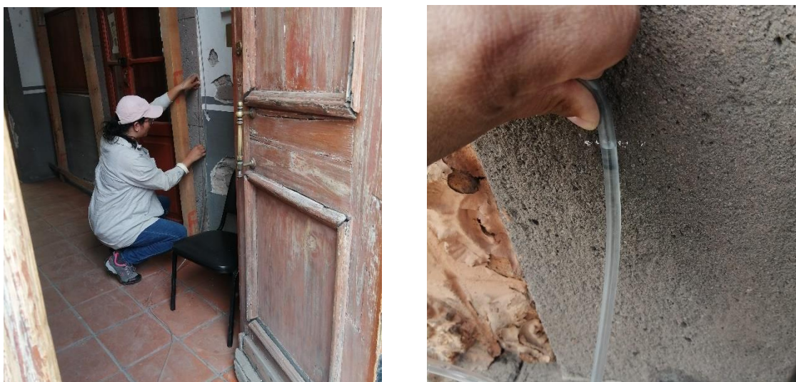
Figura 18 y 16.1. Traslado de nivel cero con manguera. Fotografía: Karina M. A.
