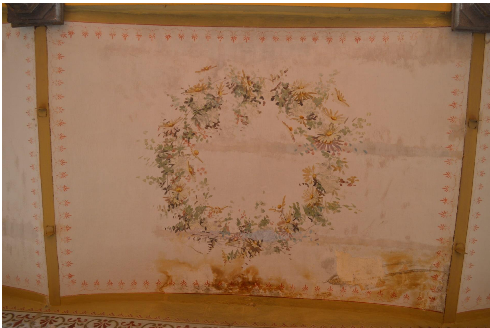
DETALLE 1. Motivo floral, circular. Estado de conservación: presenta eflorescencias salinas, marcas de humedad, laguna en la parte inferior
