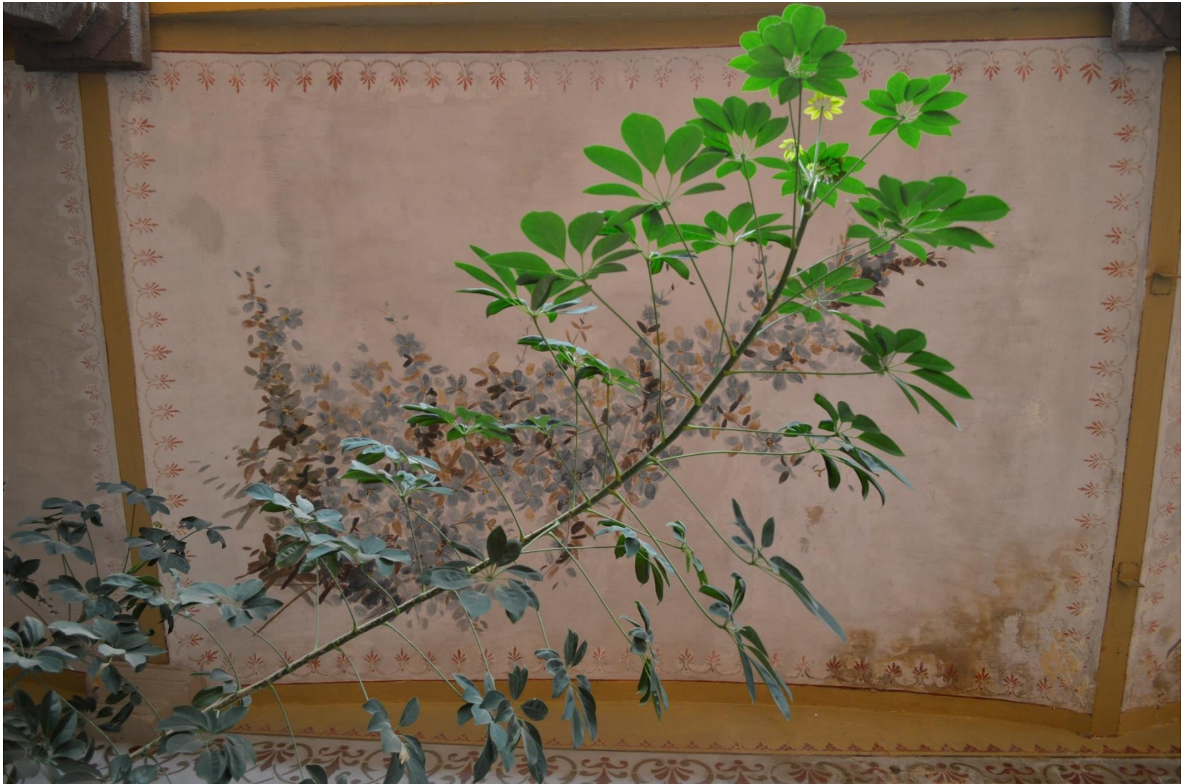
DETALLE 7. Motivo floral, ascendente de costado inferior izquierdo a costado superior derecho. Estado de conservación: presenta eflorescencias salinas y marcas de humedad en costado inferior derecho.
