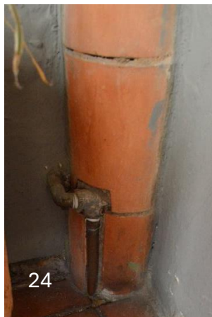
Figura 27. Ranuración de muro para integrar instalaciones.
