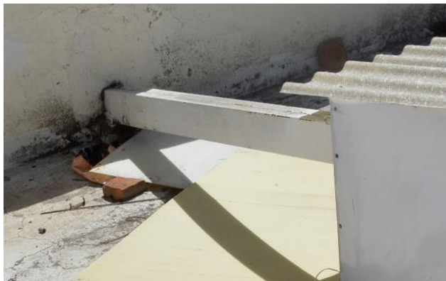
Figura 30. Empotre de estructura a corona de muro.
