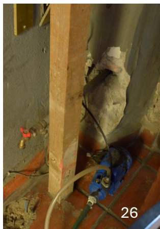
Figura 29. Ranuración de emuro para integración de instalación hidráulica.
