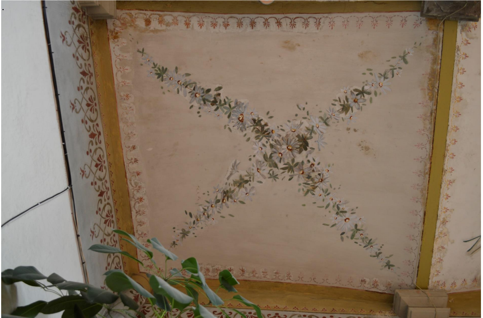
DETALLE 13. Motivo floral, en cruz. Estado de conservación: presenta marcas de humedad generales.
