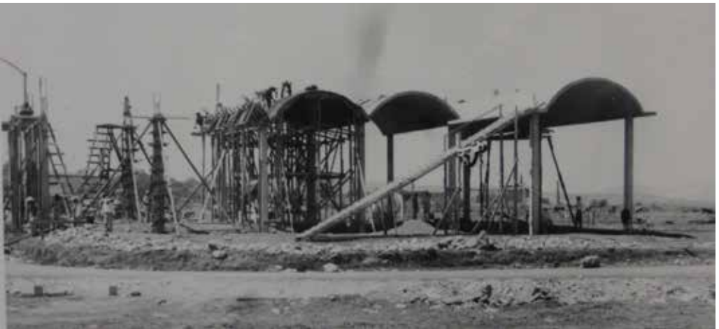
Fig. 55 Detalle de cimbrado y construcción de los conoides en la nave principal. Archivo Max Cetto, UAM-A
