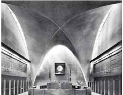
Fig. 36 Banco Industrial de Monterrey, México, D.F., 1956. Arquitecto: Enrique de la Mora. Constructor de la bóveda: Félix Candela. pp 138.
