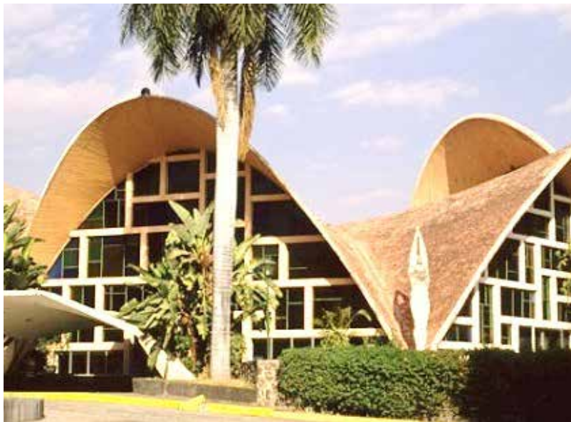
Fig. 110. Uno de los cascarones del desaparecido Casino de la Selva
