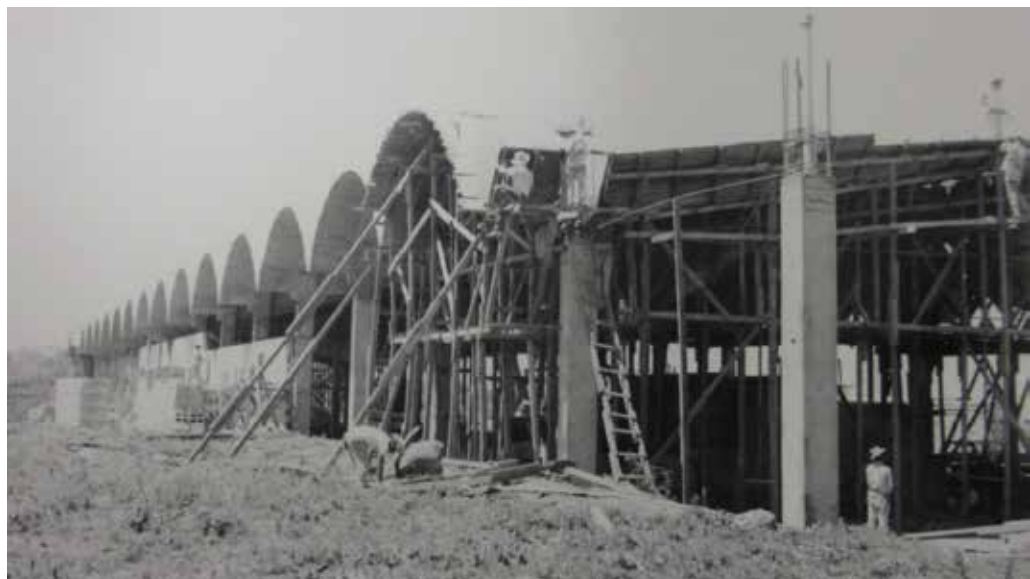
Fig. 56 Proceso constructivo y detalle del encofrado de las bóvedas corridas. Archivo Max Cetto, UAM-A
