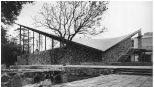
Fig. 22 Capilla de los misioneros del Espíritu Santo, Coyoacán, México, D.F., 1956. Arquitecto: Enrique de la Mora, Constructor Félix Candela. (pp 38).
