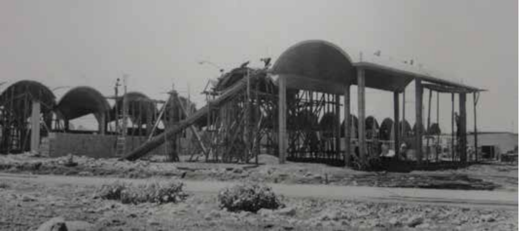
Fig. 54 Proceso constructivo de las cubiertas en cuarto de máquinas y nave principal. Archivo Max Cetto, UAM-A
