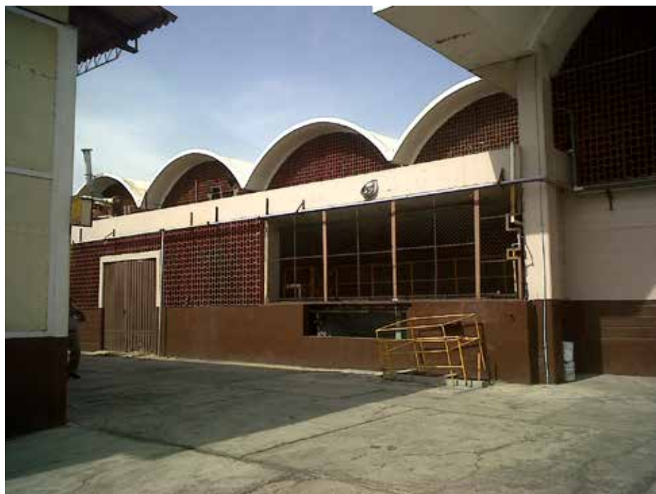
Fig. 83 Estado actual de la fachada de la nave (2012). Fotografía: Luis Manuel Chacón
