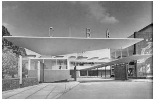
Fig. 35 Laboratorios CIBA, Churubusco, D.F., 1954. Arquitecto Enrique Manzanares. Colaborador técnico: Félix Candela. (pp 126). (demolido).
