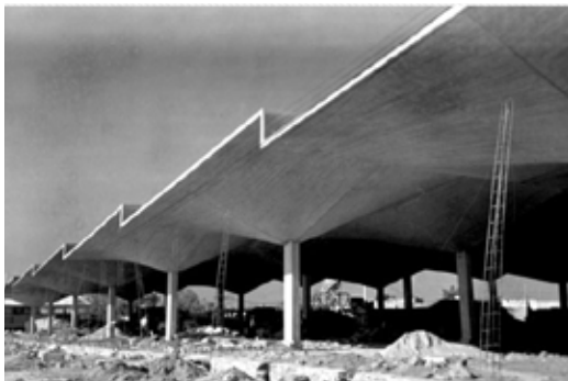
Fig. 30 Almacenes con cubiertas de paraguas.
