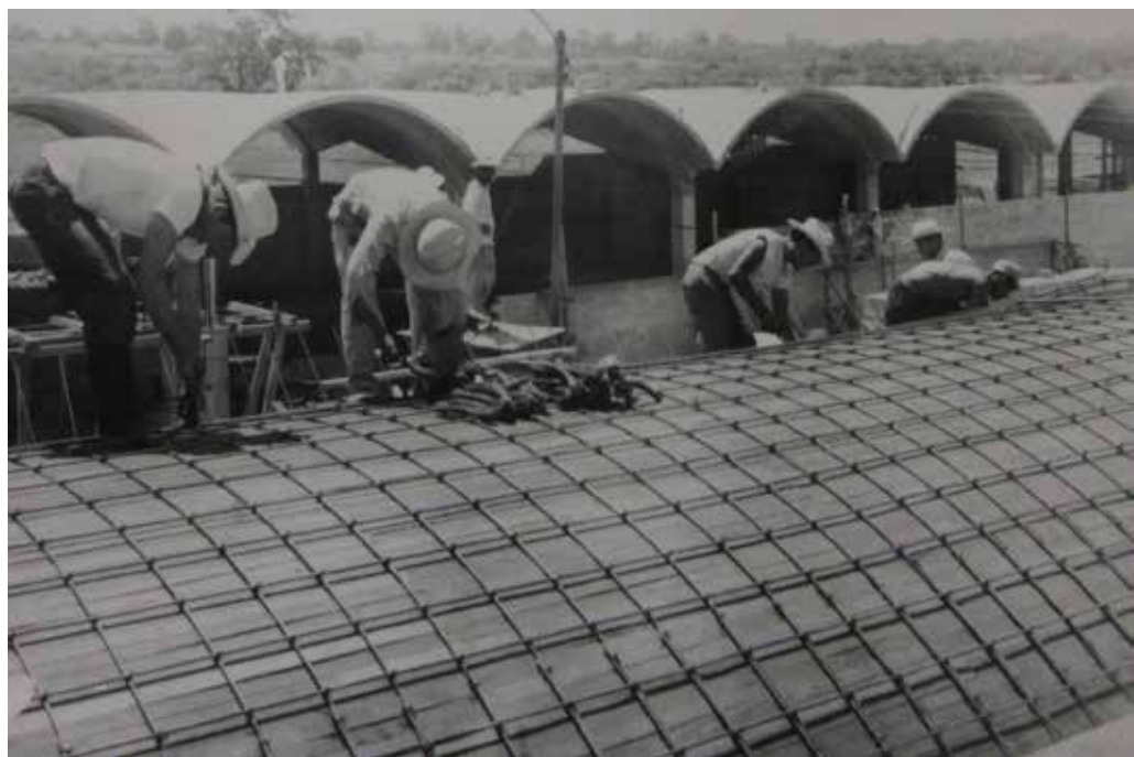
Fig. 57 Detalle del amarre de las varillas para las bóvedas corridas. Archivo Max Cetto, UAM-A
