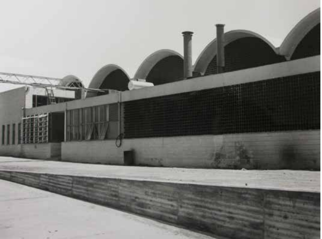
Fig. 48 Fachada original de la nave principal. Archivo Max Cetto, UAM-A
