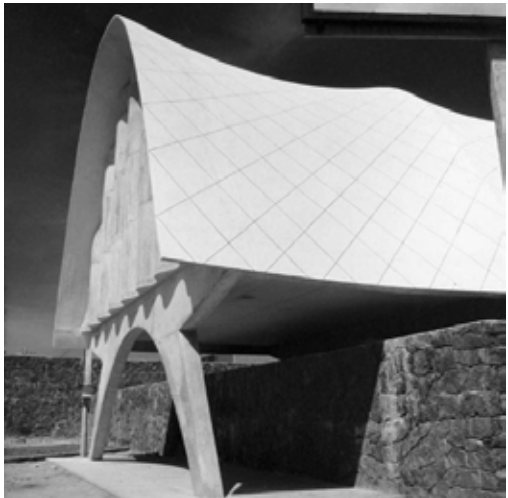
Fig. 23 Pabellón de Rayos Cósmicos, Ciudad Universitaria, México D.F. 1953. Arquitecto: Jorge González Reyna. Constructor: Félix Candela (pp 81)
