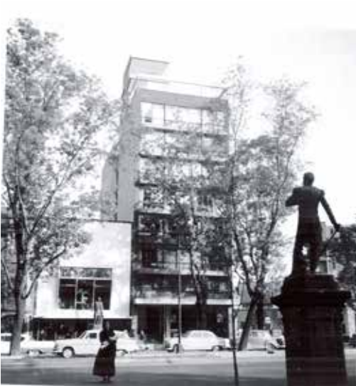
Fig. 37 Edificio de oficinas de la Aseguradora Reforma, México, D.F. Arq. Max Cetto (pp 146).
