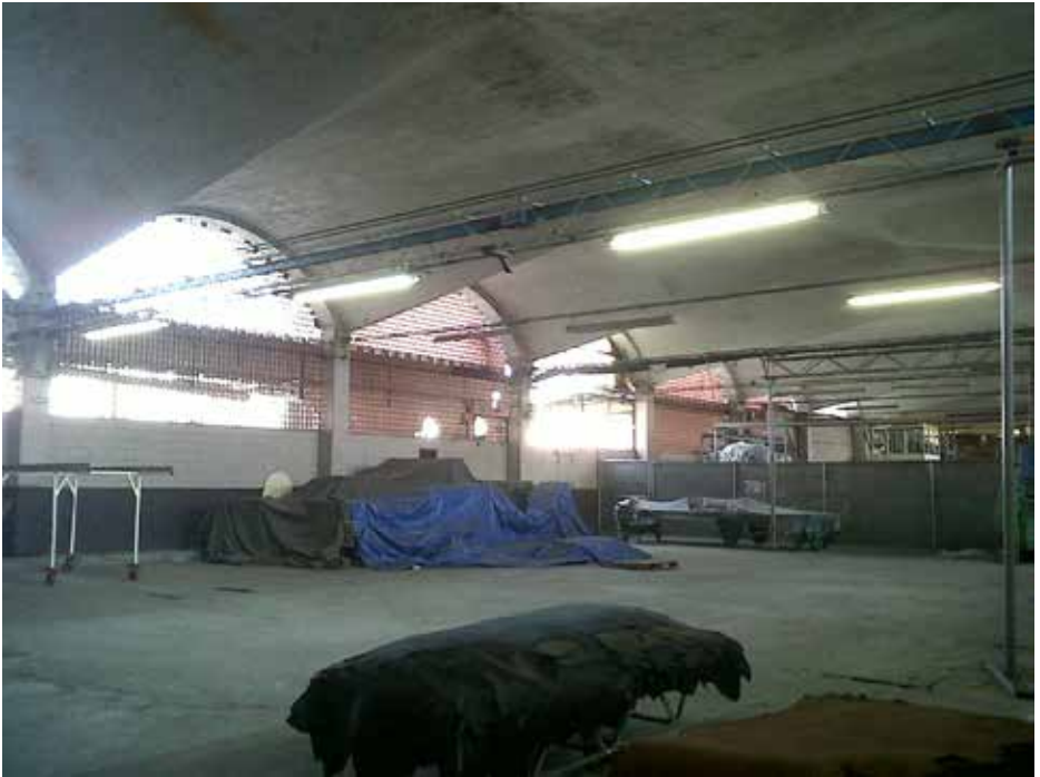
Fig. 84 Estado actual del interior de la nave (2012). Fotografía: Luis Manuel Chacón
