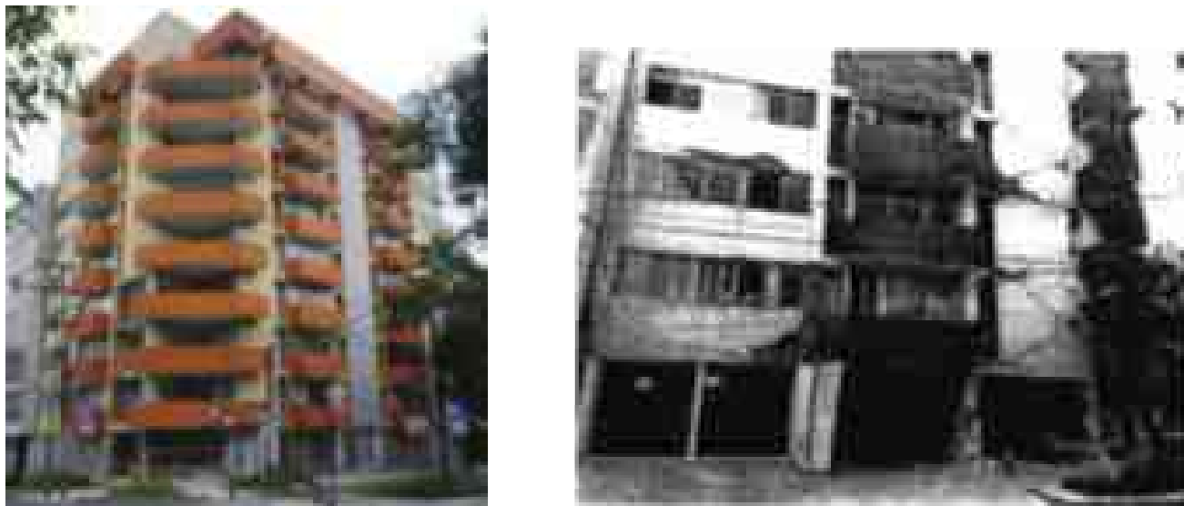
Fig. 4.1: Multifamiliar localizado en Morelia 107.
