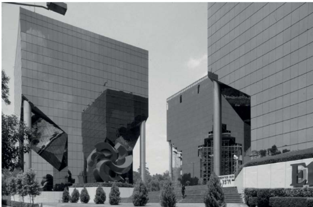
Figura 4. Torre Esmeralda, Oficinas. México DF. FIBRA DANHOS Fotografía de acceso libre en internet.
