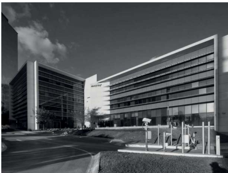
Figura 8. Oficinas en el Parque. Edificio de Oficinas Monterrey, Nuevo León. FIBRA MTY.
