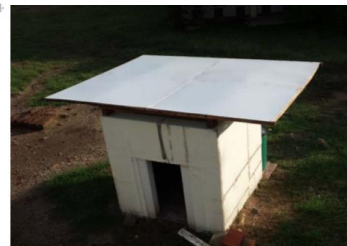
Fig. 14. Sobrecubierta instalada en módulo 07. Fuente: Autor.
