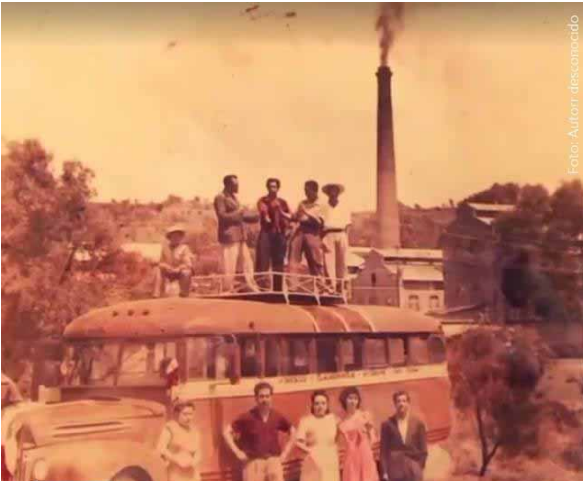
Figura 7. Fotografía histórica de la Fábrica de Progreso Industrial
