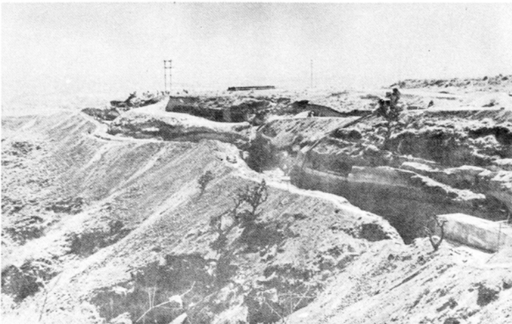
Excavaciones para el by-pass en Las Palmas.
