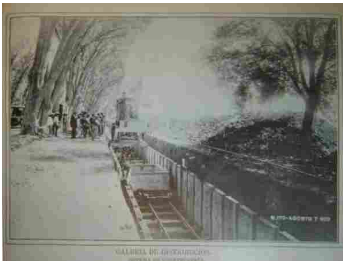
Figura 59. Construcción de la Galería. Memoria de las Obras de Provisión de Agua Potable de la Ciudad de México, 1910
