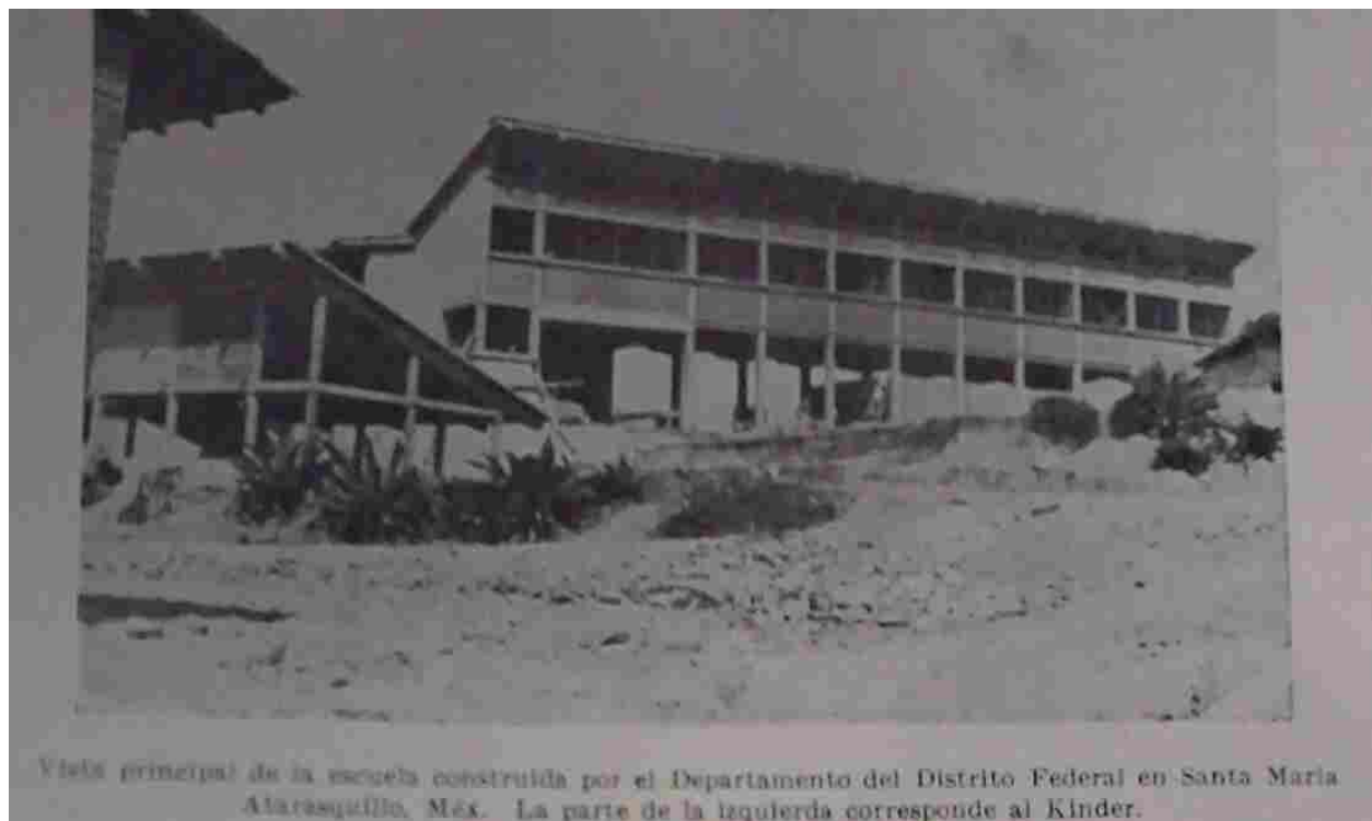
Figura 113. La escuela de Atarascuillo en construcción, Obras del Lerma, 1949, 71
