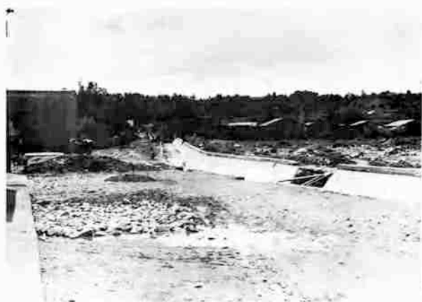
Canal de desagüe para protección de los manantiales de Ameyalco.
