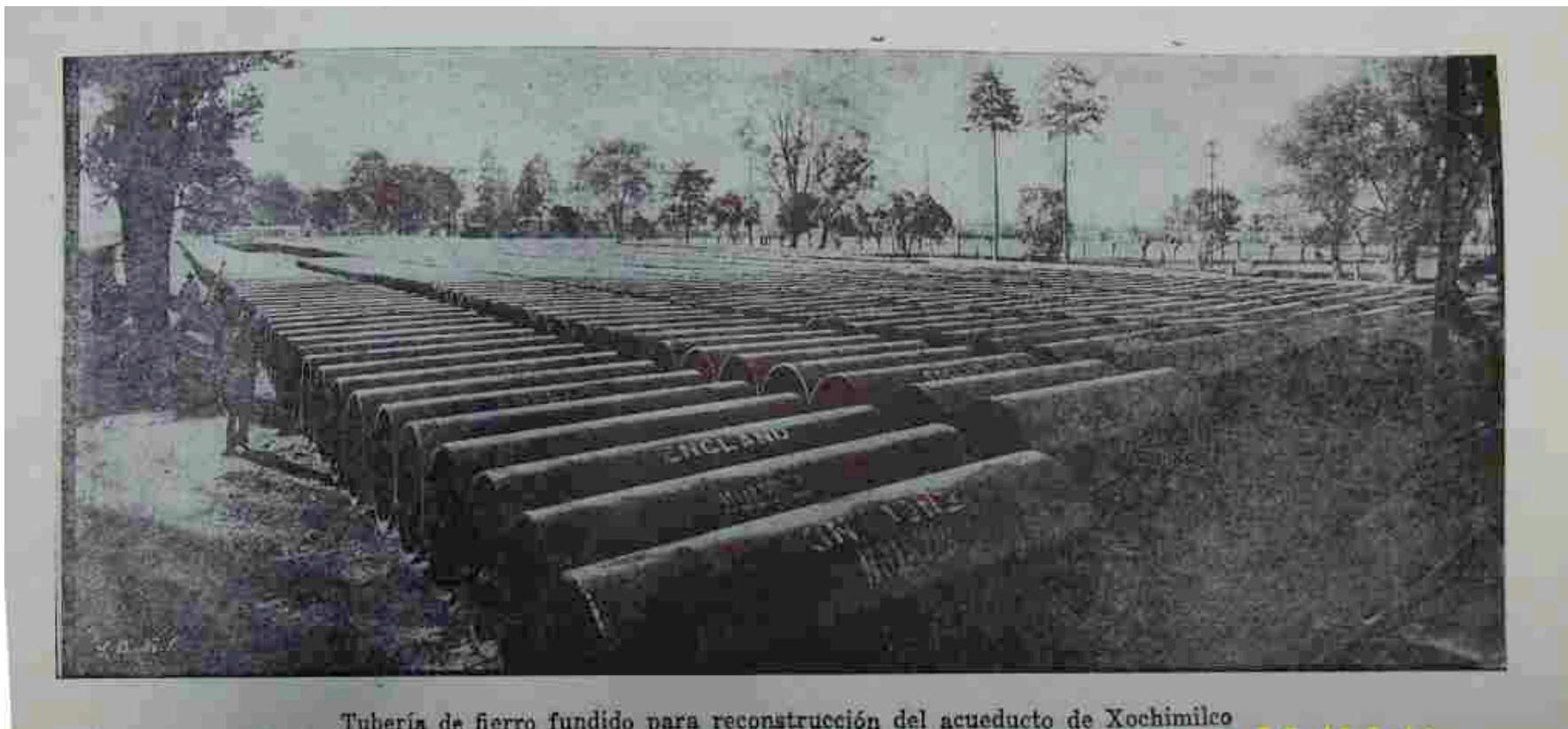
Figura 86. Tuberías de Fierro fundido para la reconstrucción del acueducto de Xochimilco. Informe que rinde C. Jefe del Departamento del Distrito Federal, de la obra se inició durante el año de 1934 a los habitantes del Distrito Federal, 1934, p.66
