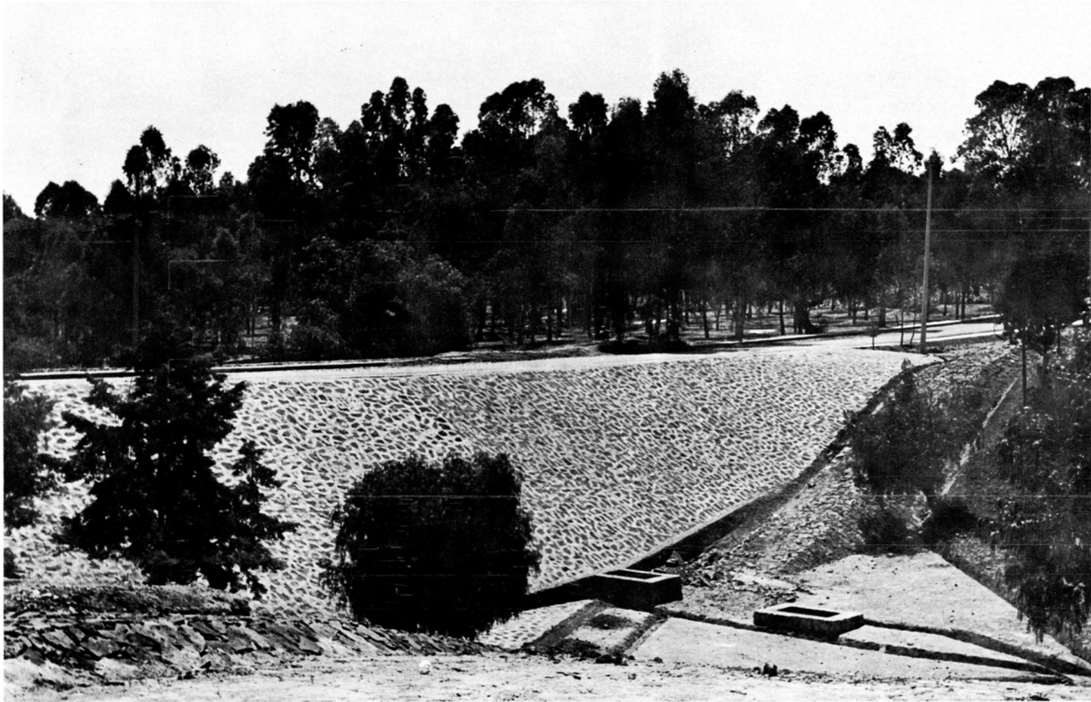
Terraplén del sifón de Dolores.
