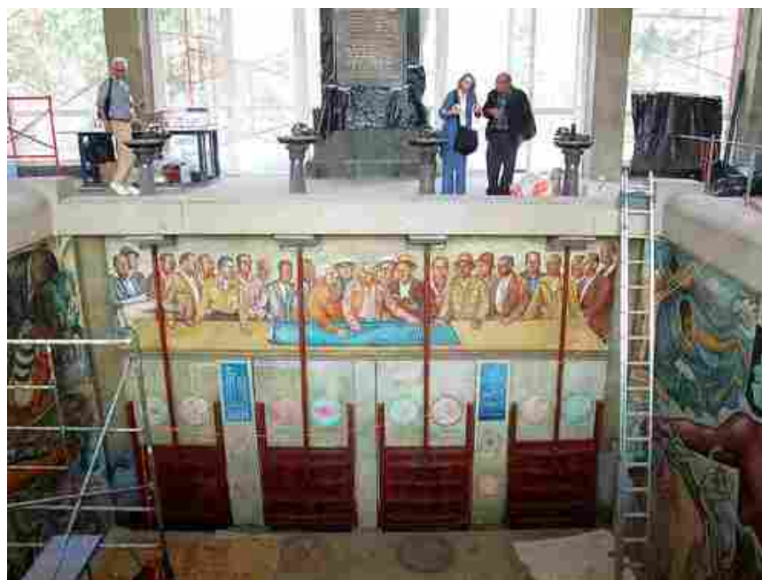
Figura 134. Proceso de restauración del Cárcamo de Dolores, 2009
