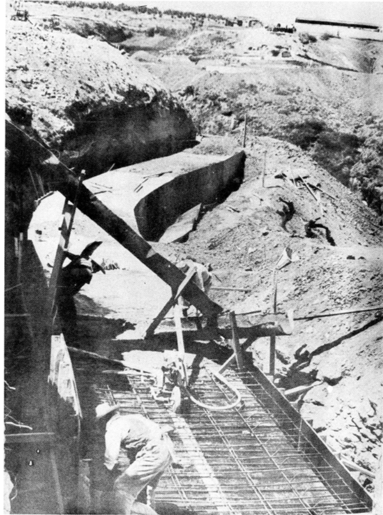
Construcción de concreto reforzado del by-pass en Las Palmas.
