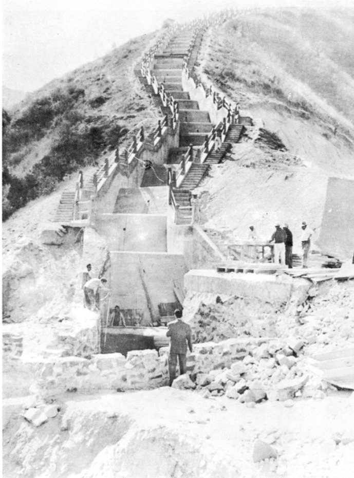
Rápida de la caída de Las Palmas y su conexión con el acueducto.
