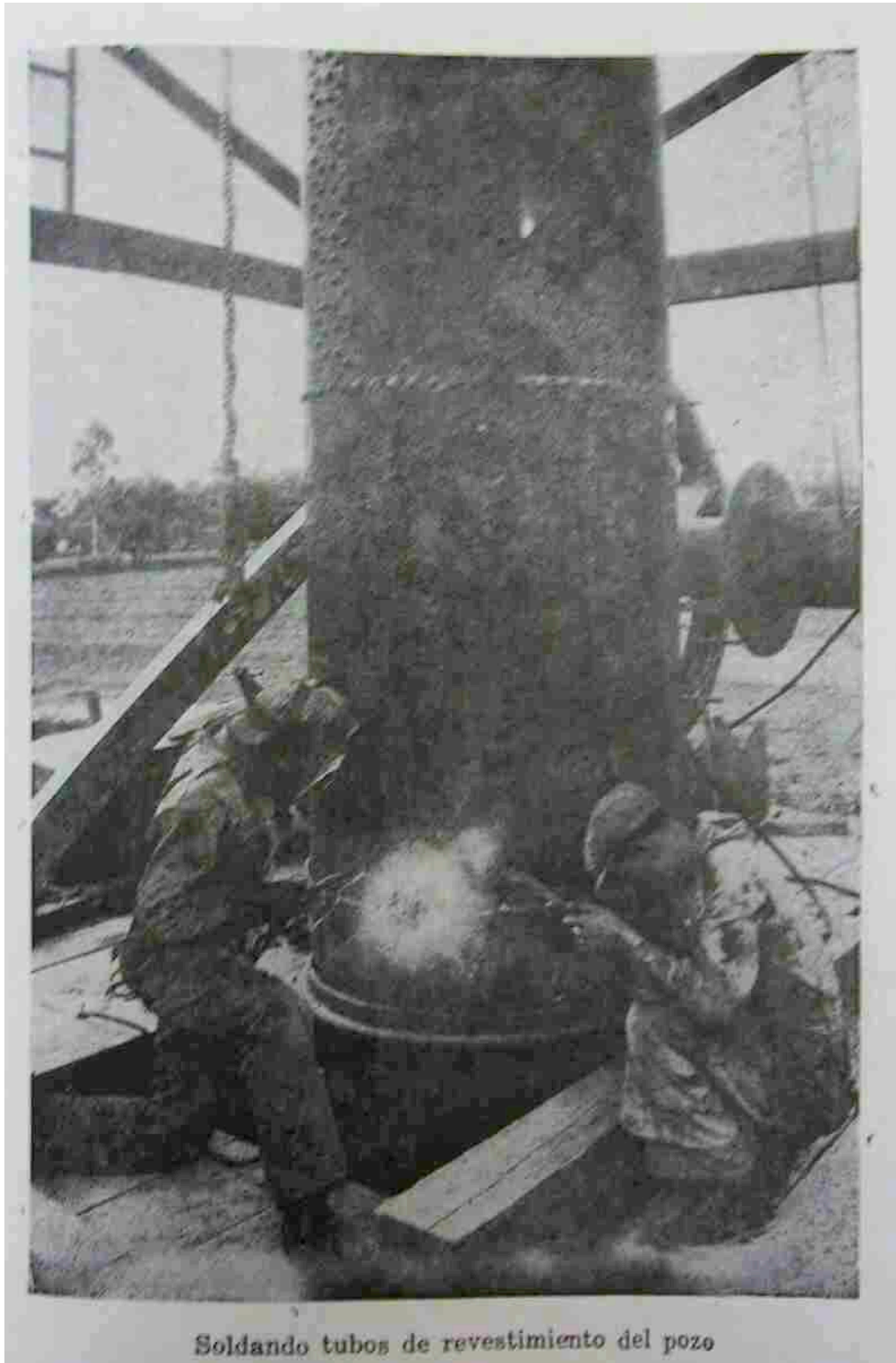
Figura 88. Pozo de Xotepingo. Soldando tubos del revestimiento del pozo. Informe que rinde C. Jefe del Departamento del Distrito Federal, de la obra realizada durante el año de 1934 a los habitantes del Distrito Federal, 1934, p.71
