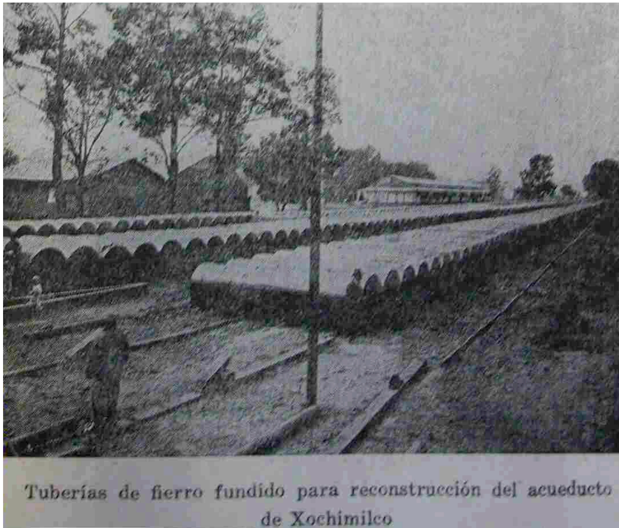
Figura 85. Tuberías de fierro fundido para la reconstrucción del acueducto de Xochimilco. Informe que rinde C. Jefe del Departamento del Distrito Federal, de la obra se inició durante el año de 1934 a los habitantes del Distrito Federal, 1934, p.65. Se rehizo el tramo entre Coyoacán y la Condesa.
