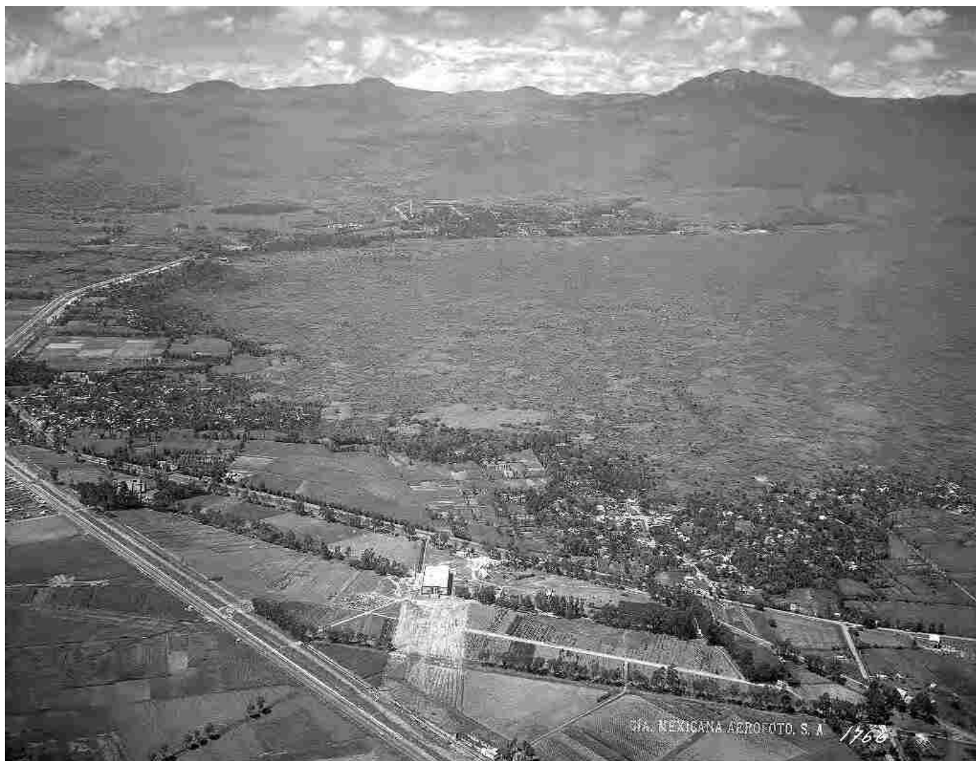
Figura 90. Bombas de Xotepingo, Cia. Mexicana Aerofoto S.A., 1940, obl_sn_001766r, Fundación ICA. En la zona que aparece en color blanco se contruyó el fraccionamiento “Ciudad Jardín”.
