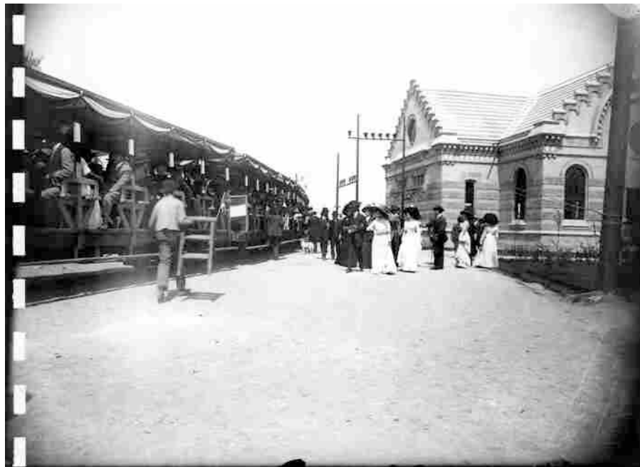
Figura 76. La Casa de Bombas de Nativitas. Inauguración de las Obras del Acueducto de Xochimilco, 1910. Fototeca de Monumentos Históricos del INAH.
