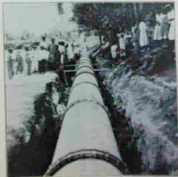
Cambio de Tubería en Sta. Cruz.—Acueducto de Xochimilco. Desmontamiento de tubería de hierro.—1932.
