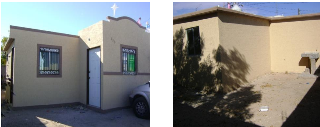
Figura 14. Fachada principal HMO4-N y fachada posterior HMO4-N
