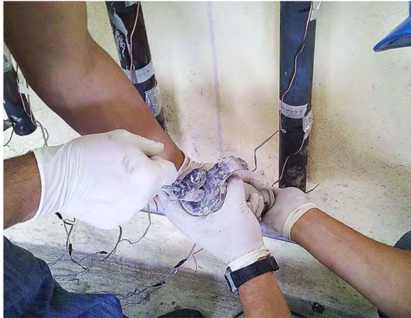
Figura 3-10 Inyección de mortero por el extremo inferior
