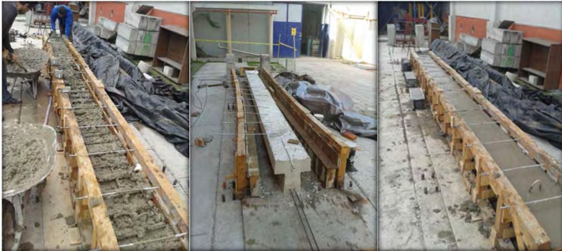
Figura 6-16 Colado de vigas y descimbrado
