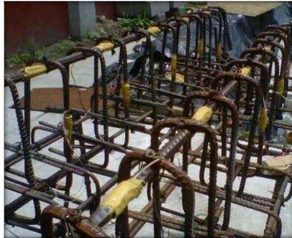
Figura 6-11 Armado de viga físico con strain gages colocados y protegidos
