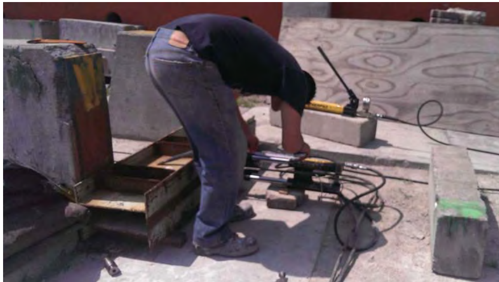
Figura 6-15 Aplicación de presfuerzo a torones
