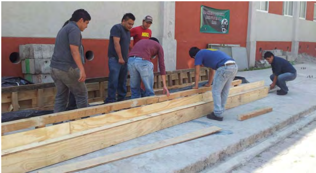
Figura 6-7 Montaje de cimbras sobre cama de pretensado
