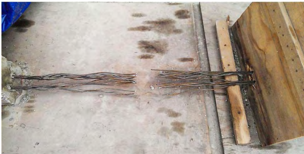
Figura 6-18 Corte de torones de presfuerzo
