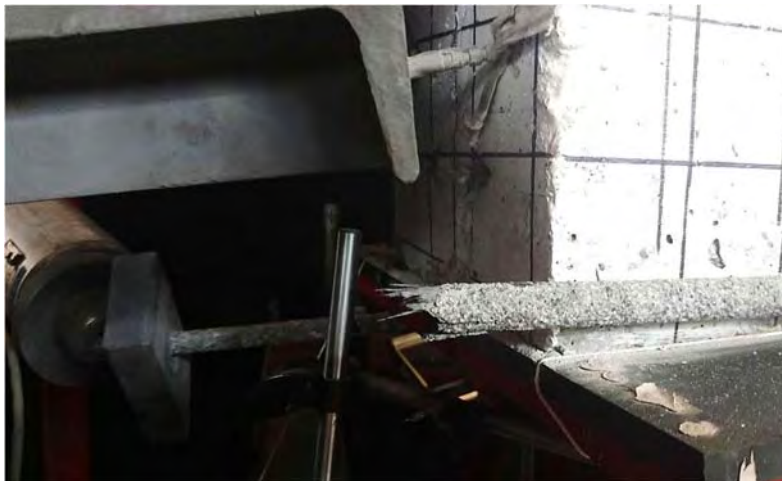
Figura 6-49 Falla por cizallamiento de las barras de PRFC en la rótula de apoyo de los anclajes
