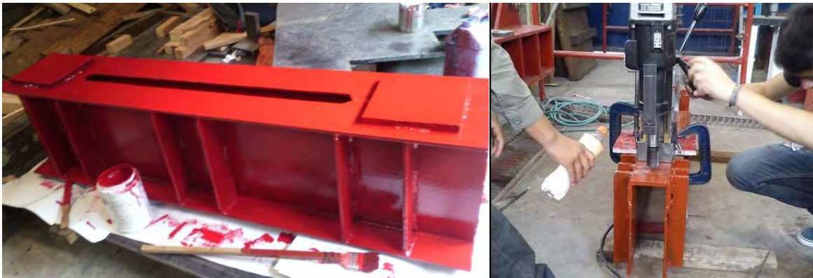
Figura 6-14 Fabricación y preparación de vigas de reacción para presfuerzo
