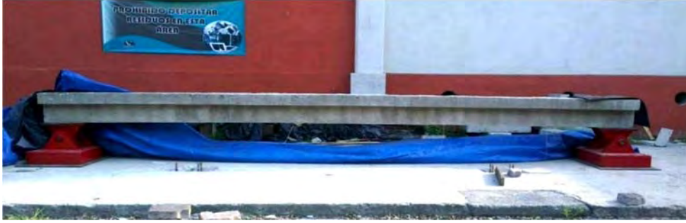
Figura 6-27 Viga sobre mesa de pretensado
