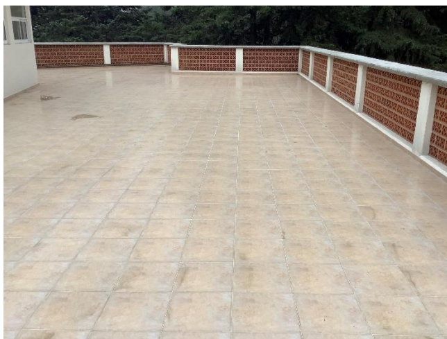
Figura 1. Superficie captación de agua de lluvia de 220m 2 .
