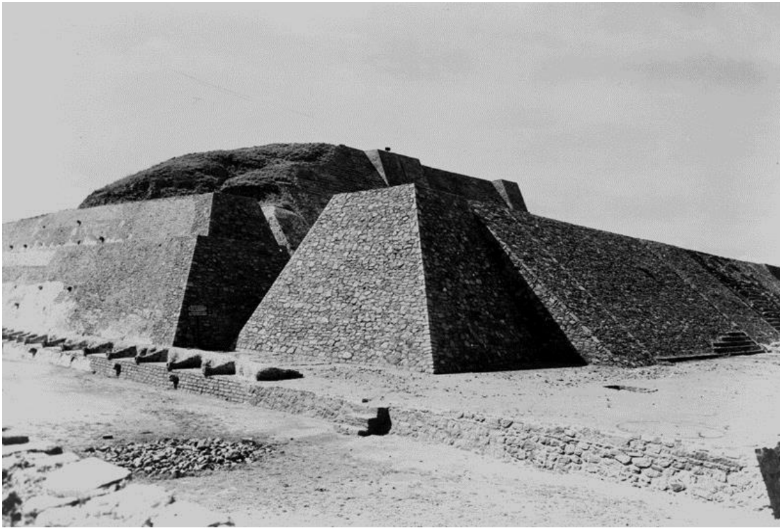
Figura 15. Templo Mayor de Tenayuca, ángulo noroeste después de la restauración (1930). Fototeca INAH.
