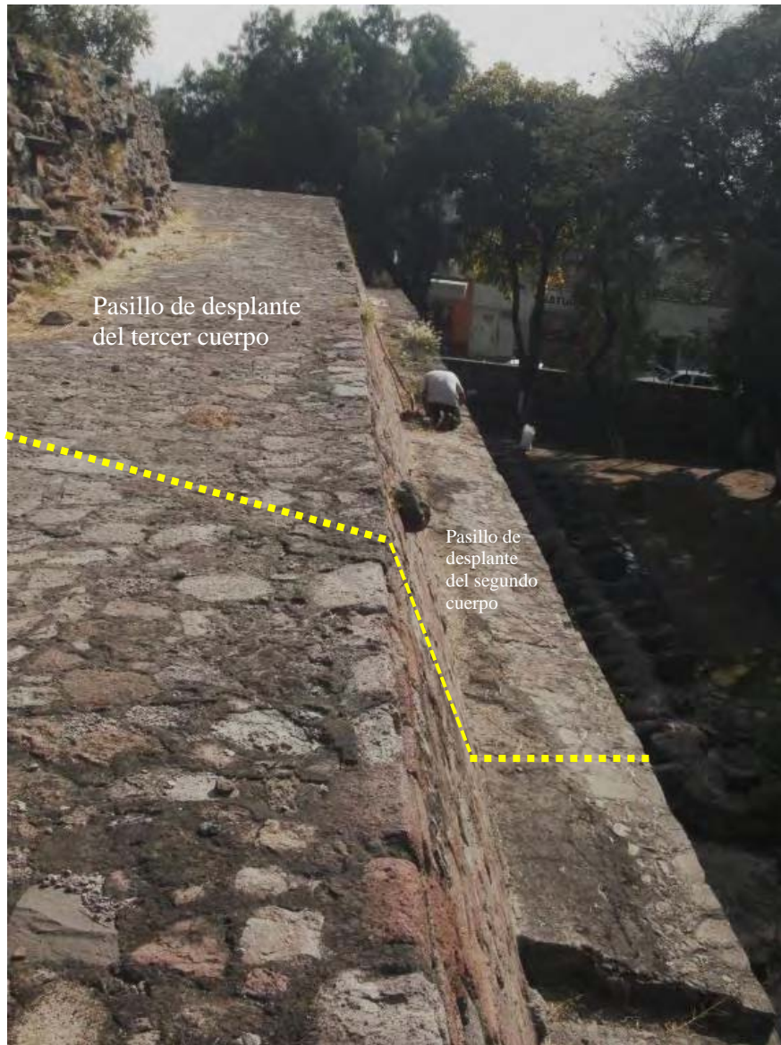
Figura 60. Pasillos del desplante del segundo y tercer cuerpos
