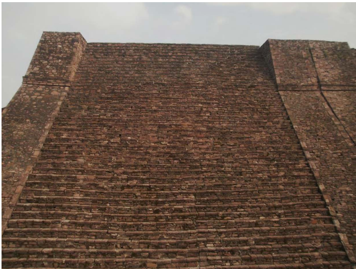
Figura 61. Escaleras de la IV y V etapas.
