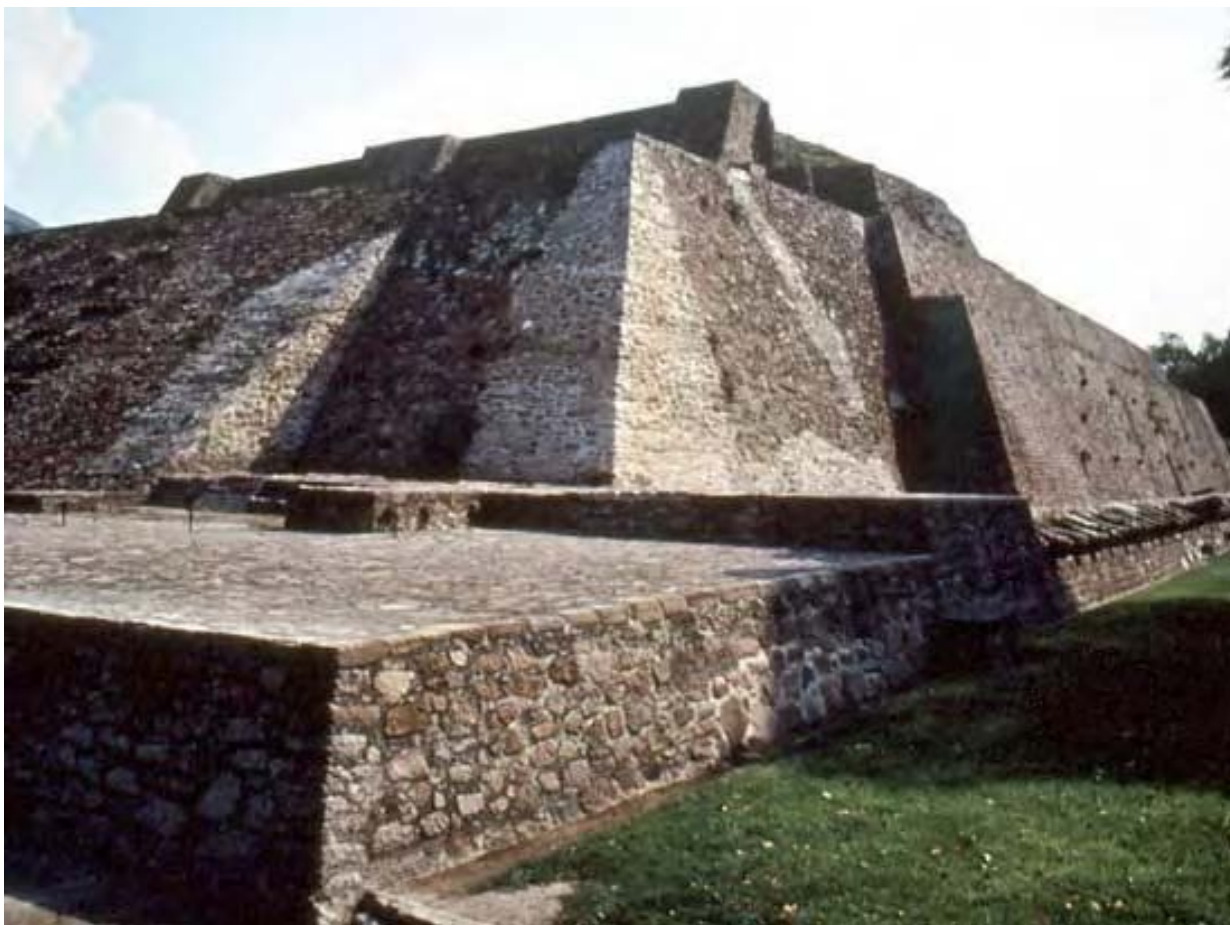
Figura 16. Esquina suroeste después de los trabajos de restauración en 1990.
