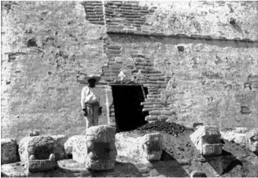
Figura 67. Estado de conservación de los aplanados en el lado oriente en la época del proceso de exploración (1925-1930) Fototeca INAH.
