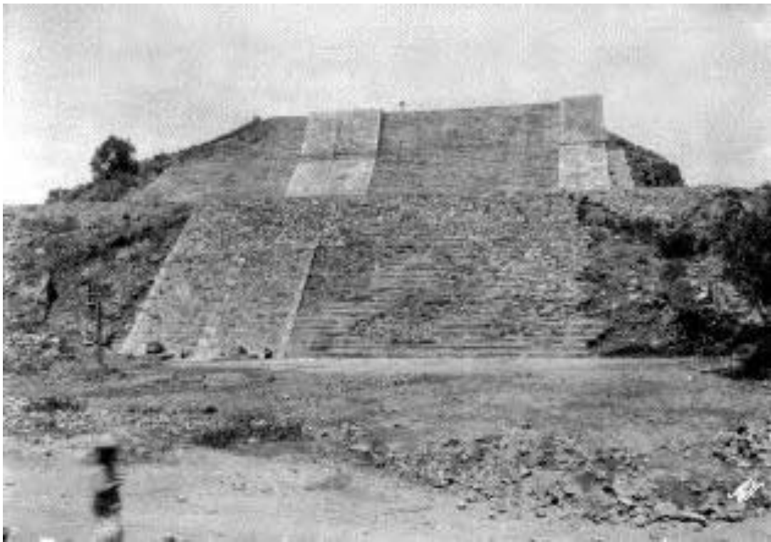
Figura 11. Proceso de excavación del frente del monumento (1925). Fototeca INAH.
