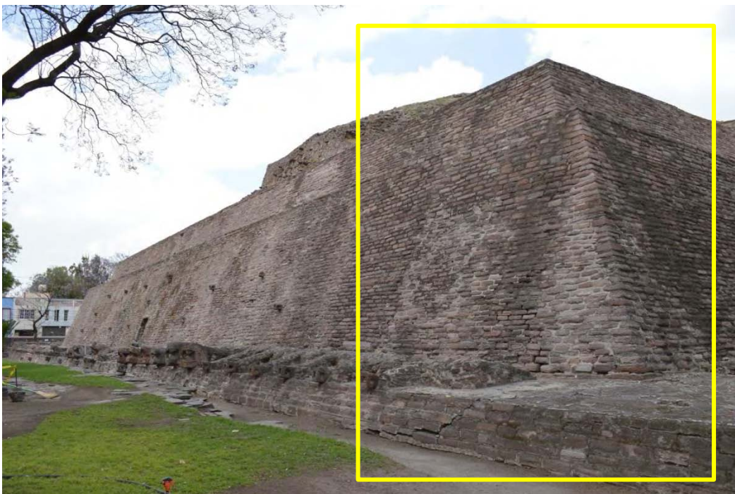
Figura 70. Grieta en la plataforma del Coatepantli y en la esquina del basamento.
