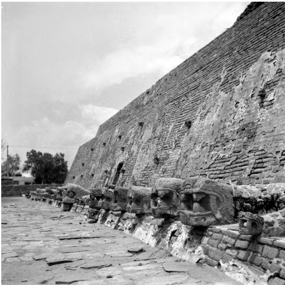
Figura 59. Muros en talud de la fachada del lado oriente (1940). Fototeca INAH, número de inventario: 312997.
