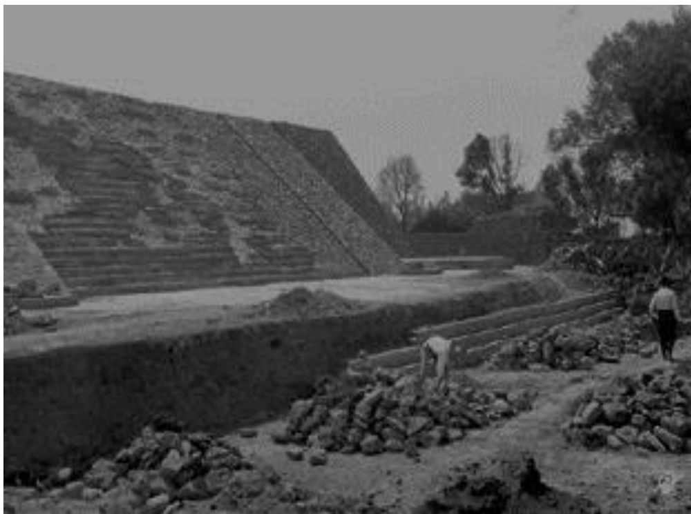
Figura 12. Proceso de excavación del lado poniente (1925-1927). Fototeca INAH.
