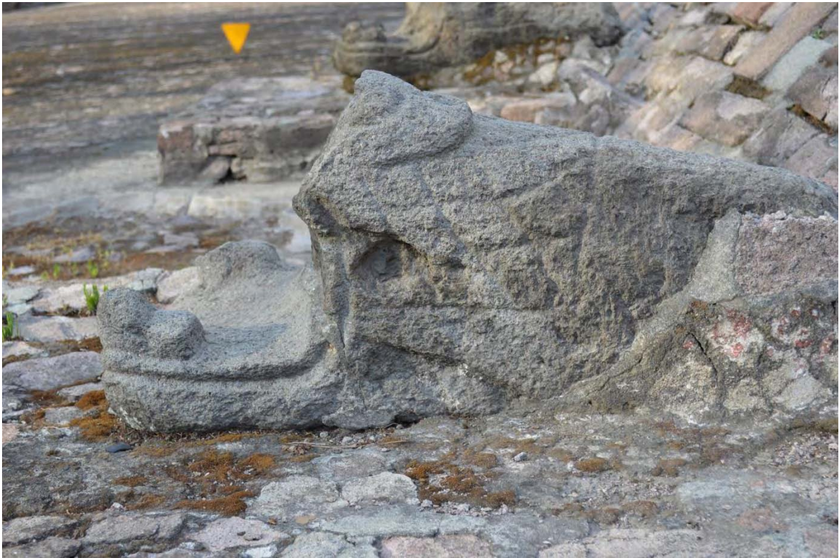
Figura 76. Deterioro de faltantes
