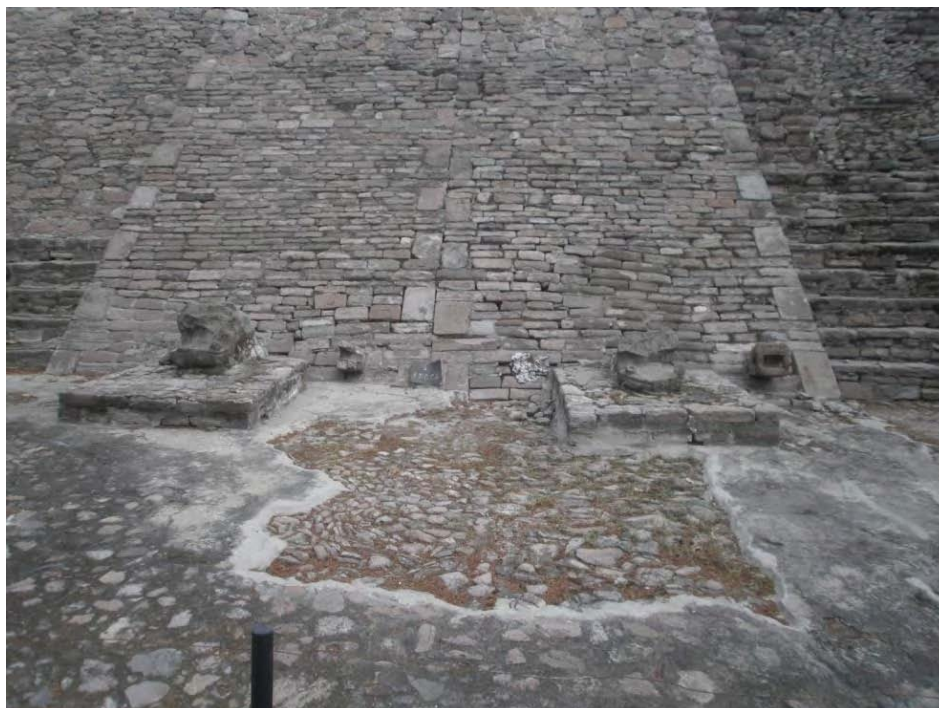
Figura 62. Alfardas de la sexta etapa constructiva. Al frente se conservan restos de pisos con aplanados.
