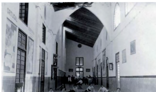
Bodegas rehabilitadas a principios del siglo XX
