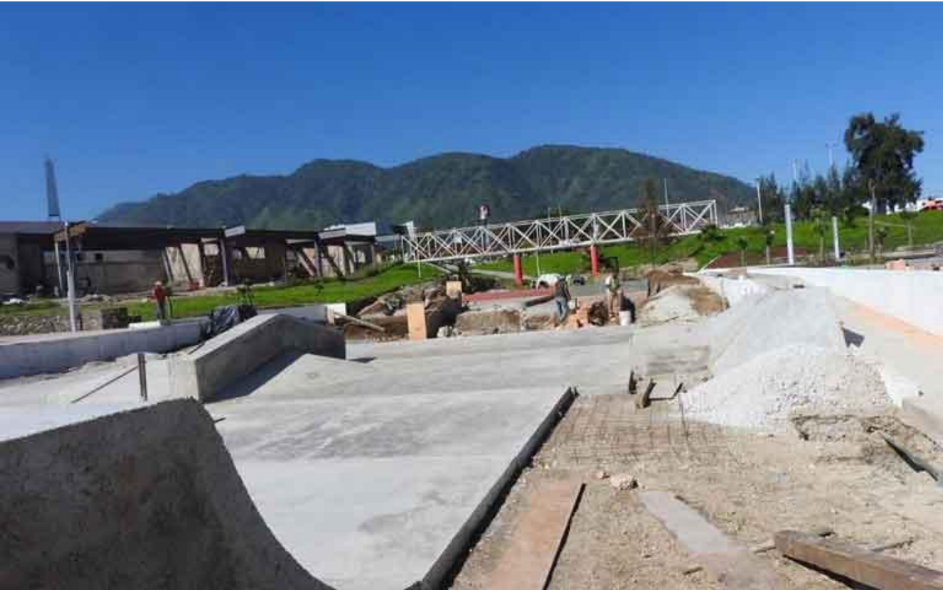
Ilustración 34 Construcción del Skate Park
