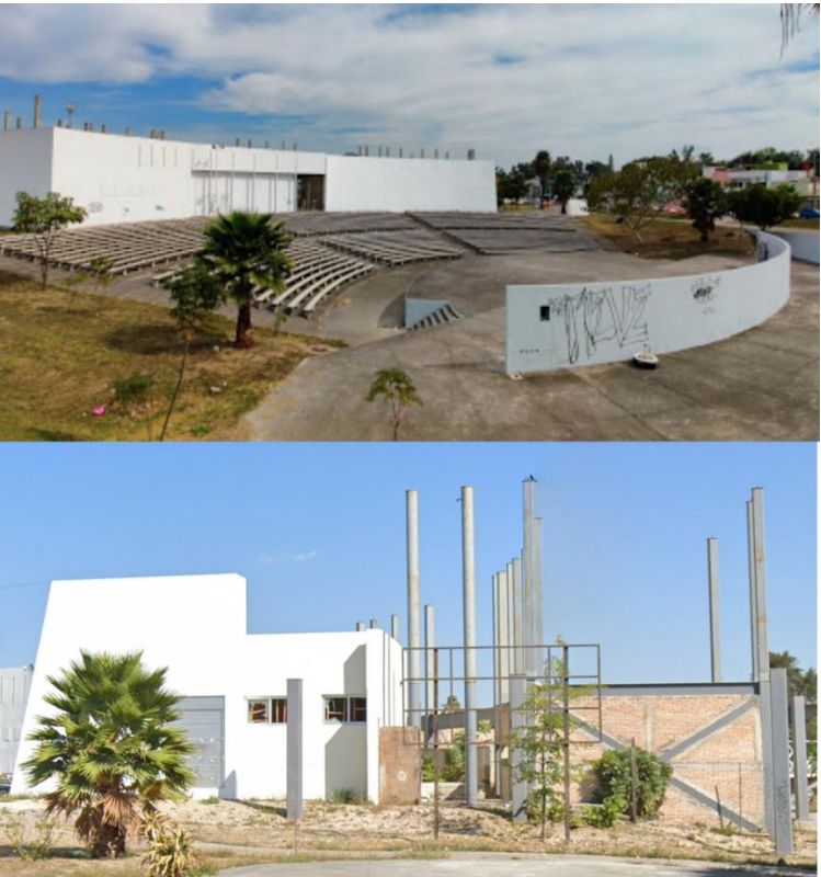
Ilustración 70 Edificio sin terminar
