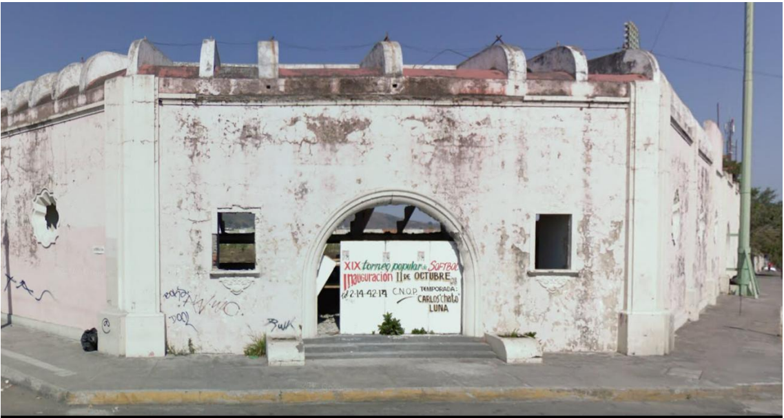
Ilustración 23 Estadio de béisbol antes de su demolición
