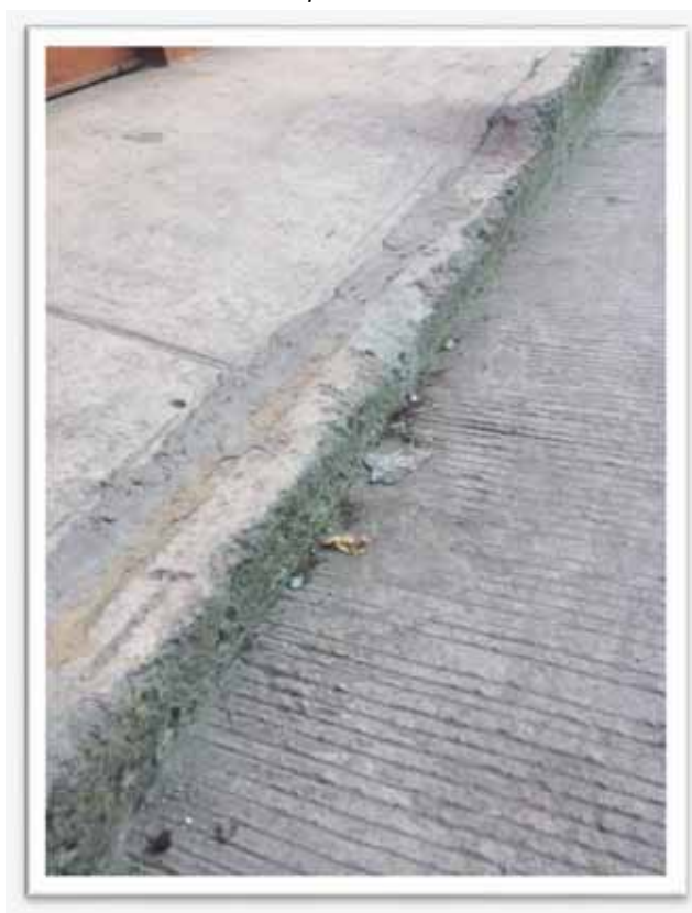
Foto 6. Rampa inadecuada
