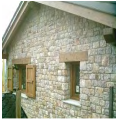
MURO DE PIEDRA CALIZA
