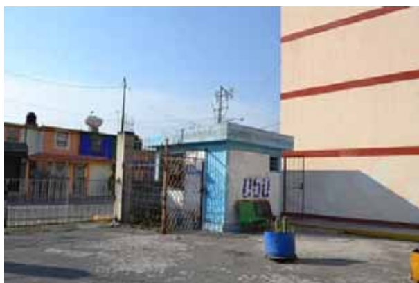
Foto 3. Caseta de vigilancia en condominios.
