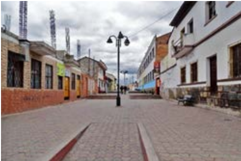
Figura 8. A la izquierda, edificación moderna en proceso de construcción y a la derecha edificaciones patrimoniales. Fotografía del autor (agosto de 2016).
