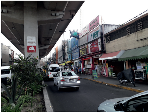
Figura 19. Inmuebles unifuncionales sobre la Av. del Molinito (Göbel, 2019).
