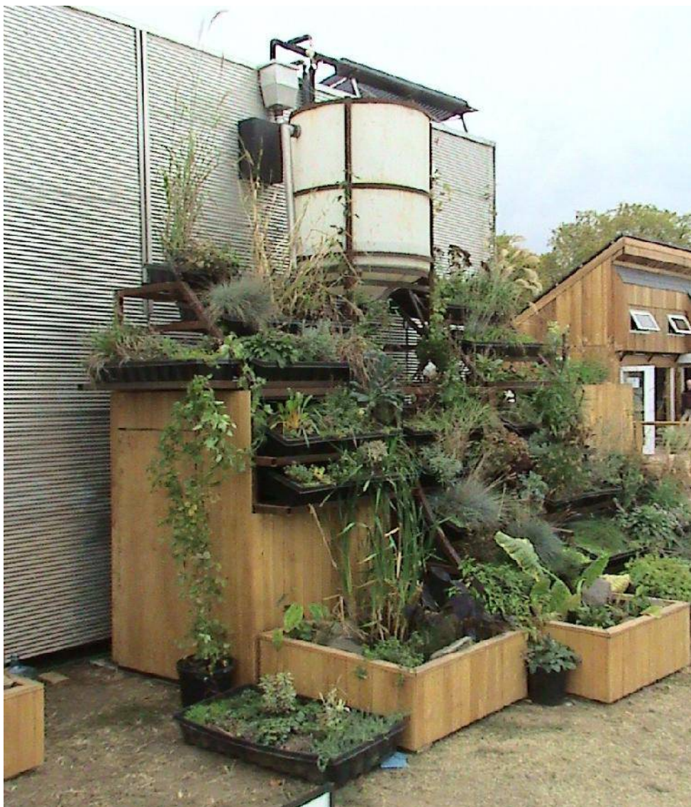
Figura 175. Sistema de tratamiento de agua para la producción vegetal urbana. Proyecto: Solar Decathlon 2007 Imagen: A. Figueroa (2007)
