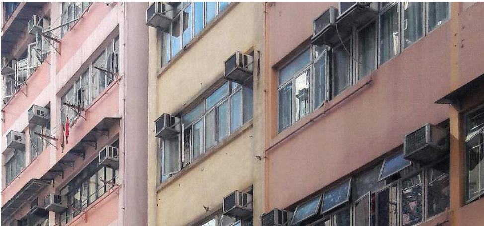
Figura 10. Síndrome del Edificio Enfermo. Instalaciones de aire acondicionado en Hong Kong Imagen: Natalia Figueroa (2018)
