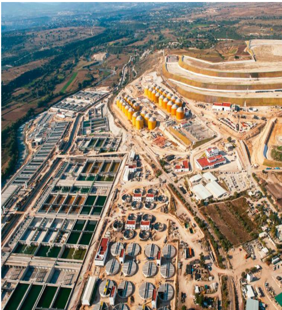
Figura 114 Planta de tratamiento Atotonilco-Tula. CONAGUA (2016). Planta de tratamiento de aguas residuales Atotonilco participa en Reto Mundial del Agua 2016 [imagen de internet]. Comisión Nacional del Agua. https://www.gob.mx/conagua/articulos/planta-de-tratamiento-de-aguas-residuales-atotonilco-participa-en-reto-mundial-del-agua-2016?idiom=es
