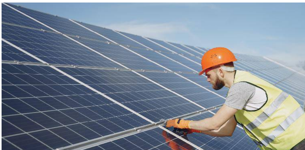
Figura 72. Hombre instalando paneles solares Fring Gustavo (2020). Clima hombre construcción industria [fotografía de internet]. Pexels. https://www.pexels.com/es-es/foto/clima-hombre-construccion-industria-4254168/
