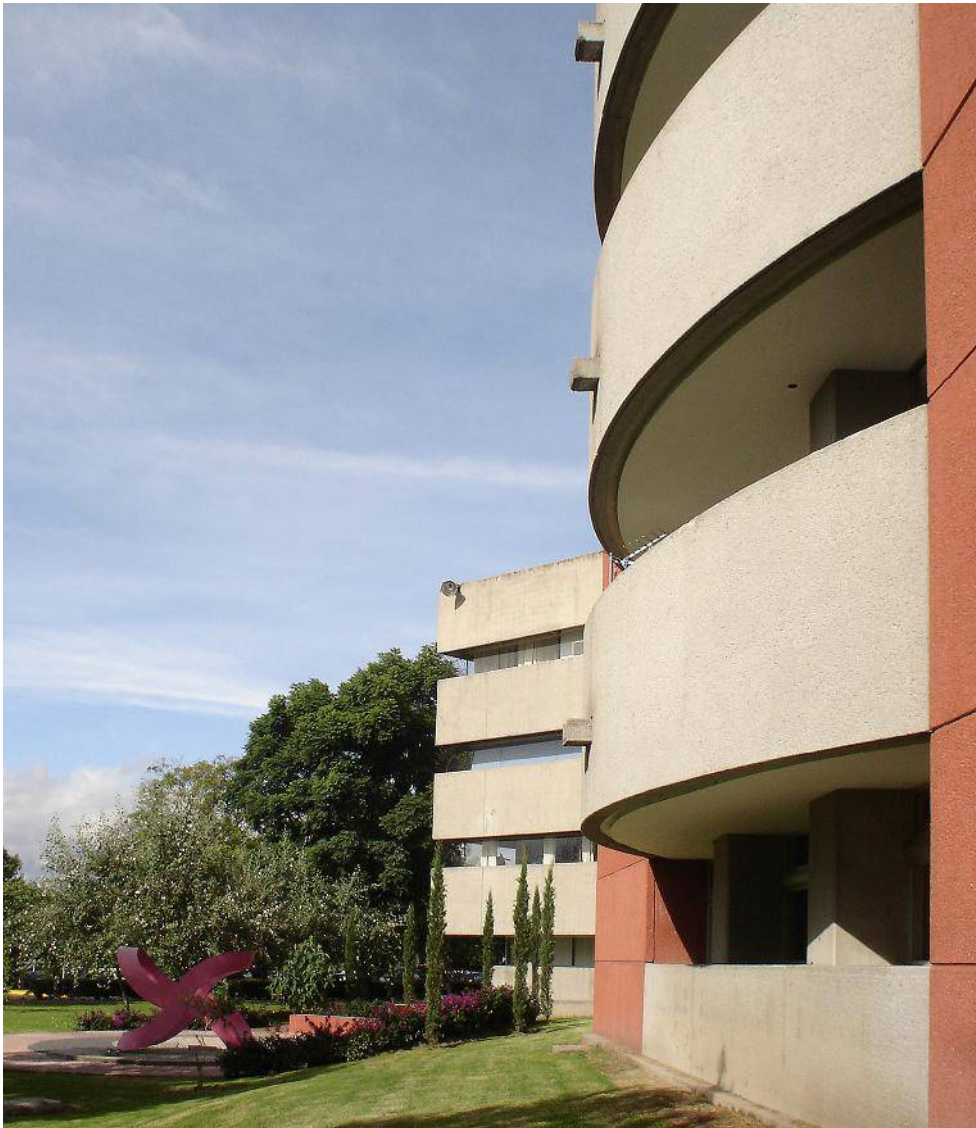
Figura 1. Edificios Anexos H, UAM Azcapotzalco, Ciudad de México. Arquitectos: A. Figueroa y V. Fuentes Imagen: A. Figueroa (2002)
