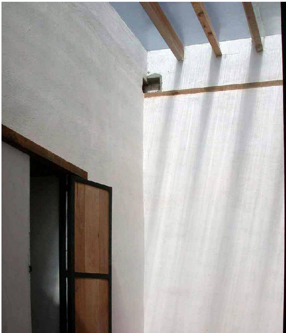
Figura 178. Preservación de construcciones con valor patrimonial. Proyecto casa Tepetzotlán II Arquitectos: G. Castorena y A. Figueroa Imagen: G. Castorena (2007)
