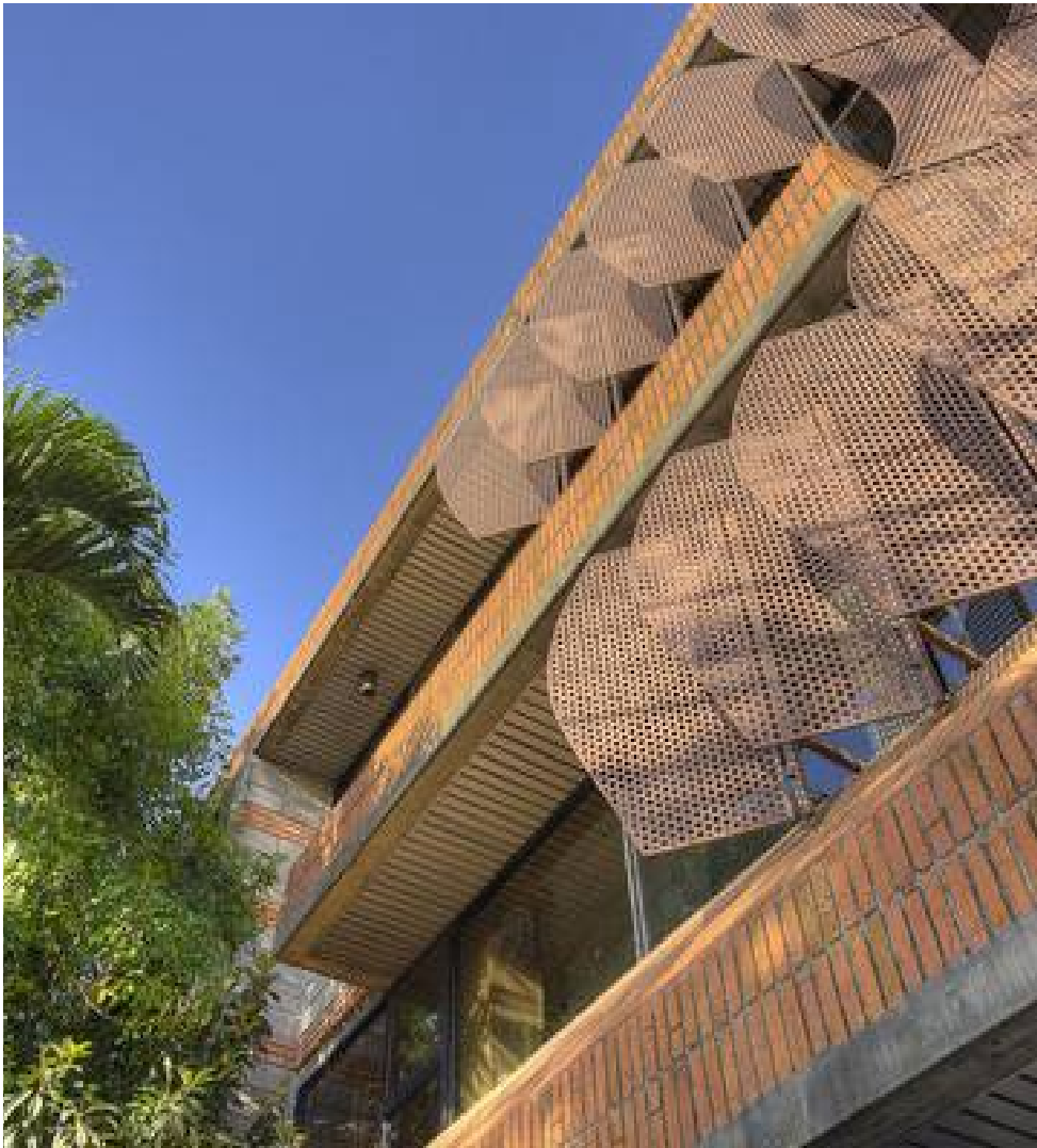
Figura 168. Arquitectura tropical en Costa Rica
