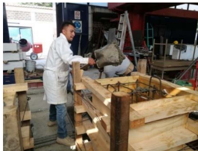
b) Colado en los apoyos
