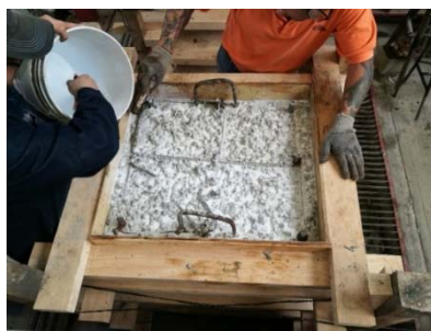
d) Colocación de fester bond
