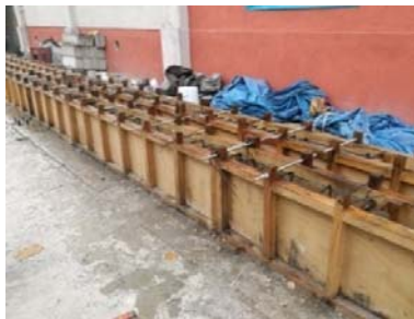
a) Cimbra acondicionada
