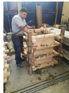
c) Vibrado del concreto
