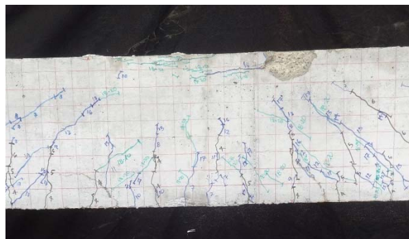
Figura E.41 Mecanismo de colapso, trabe 45-3E-1.5
