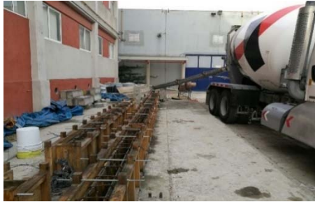
a) Distribución del concreto
