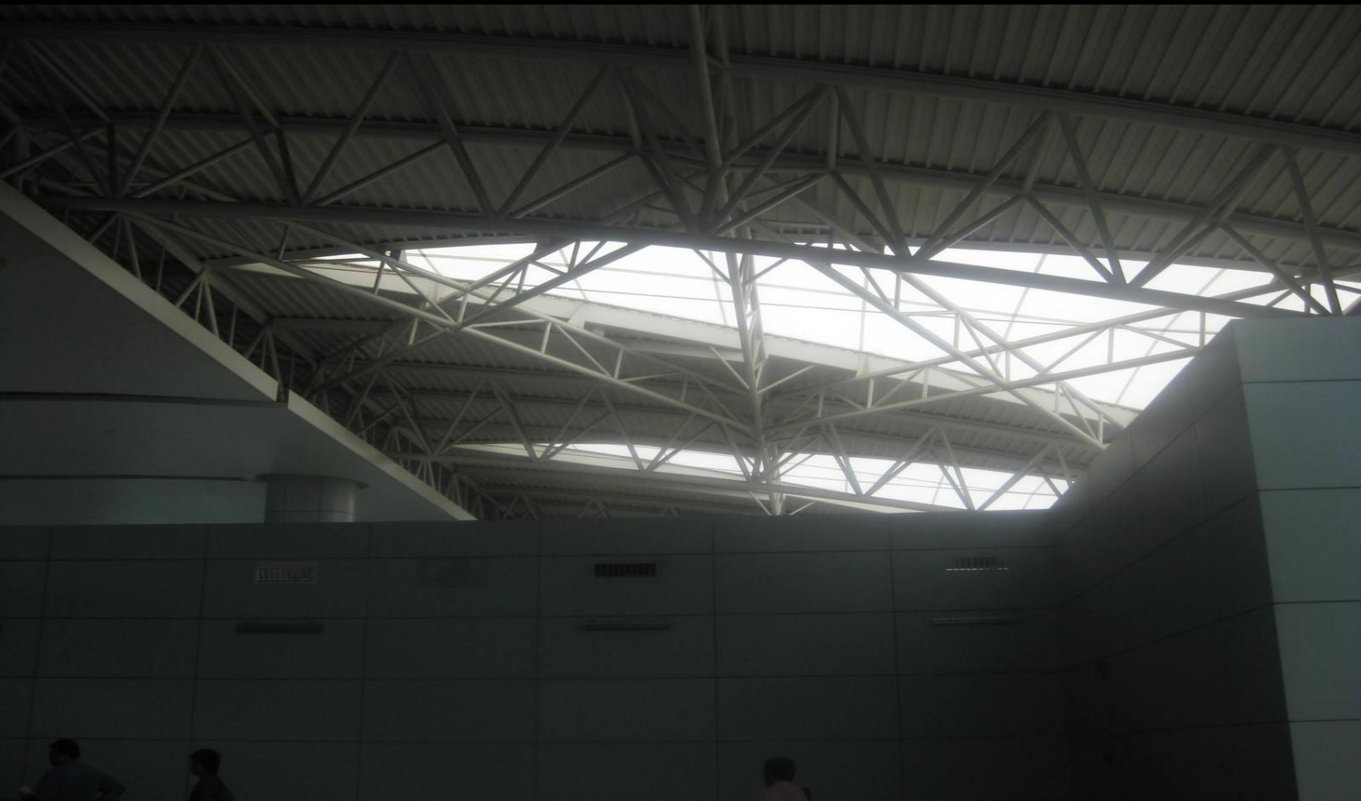
Detalle de la estructura, donde se hace cambio de material en la cubierta para permitir la entrada de luz.
