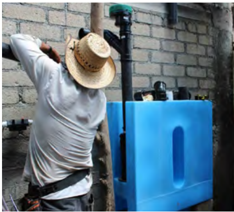
Figura 5. Sistema Tlaloque de Isla Urbana (islaurbana.mx/project/manualesyficahastecnicas/).
