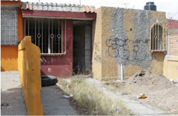
Figura 18. Necesidad de reutilizar los inmuebles desocupados ( http://www.heraldo.mx/quieren-tomar-control-de-viviendas-abandonadas/ ).
