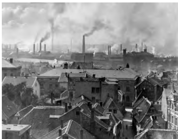
Figura 1. Ciudad minera de Essen, Alemania vista general de la ciudad (commons.wikimedia.org/wiki/File:Essen_a54_v_Stadtpanorama-1890.jpg).
