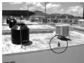
Figura 7. Dispositivo de medición del flujo de agua marca Altair clase CI (Luis Carlos Herrera Sosa).
