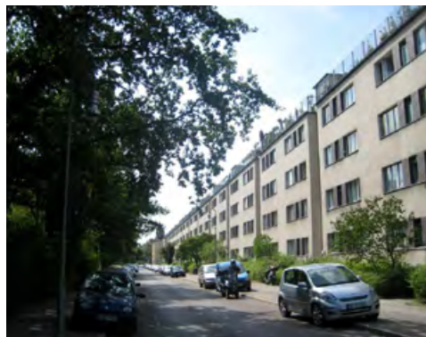
Figura 25. Walter Gropius. Siemensstadt. Fachada este ( www.disenoyarquitectura.net/2010/01/colonia-siemensstadt-edificios-de.html ).
