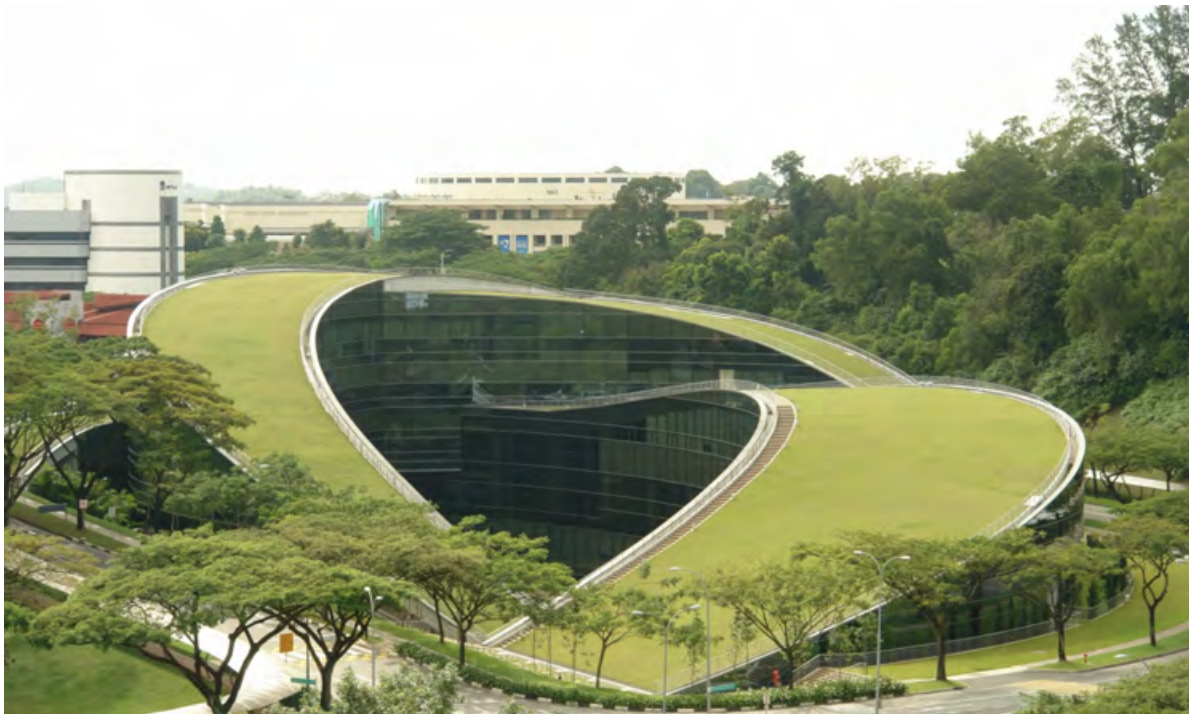
Figura 3. Tratamiento de cubiertas completamente verdes fue la estrategia llevada a cabo para el edificio del School of Art and Media de la Universidad Tecnológica de Nanyang, Singapur (Google maps).
