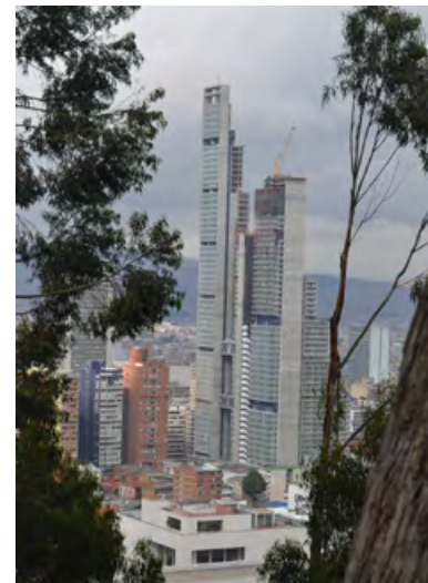
Figura 15. Uso de estándares máximos en la construcción. Bogotá, Colombia (Elizabeth Espinosa, 2016).
