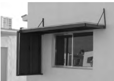
Figura 5. Protección solar en ventanas (Luis Carlos Herrera Sosa).
