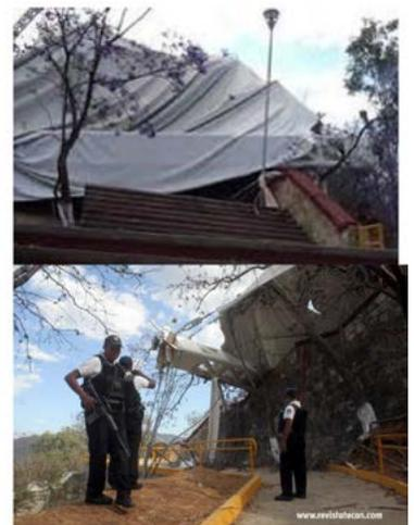
Estructura de velaria colapsada por fuerzas aerolásticas.
