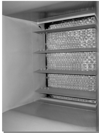
Figura 37: Campana de entrada con las persianas, nótase la disposición de las persianas.
