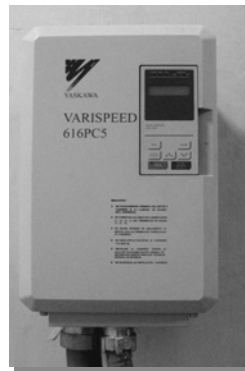
Figura 33: Control eléctrico tipo Varic.
