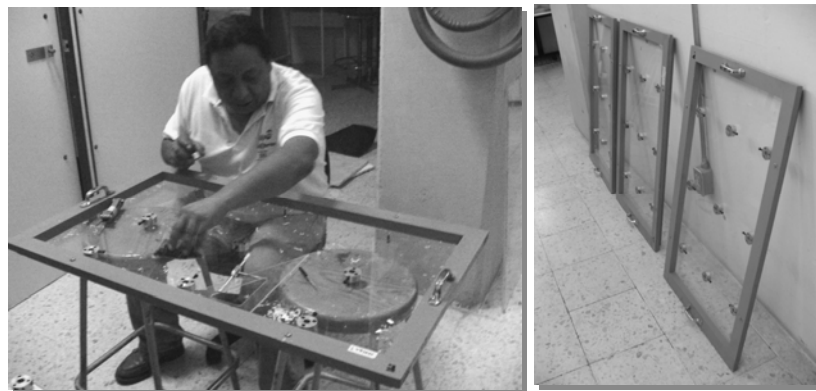
Figura 41: Perforación y colocación de soporte. Figura 42: Ventanas con soportes instalados.
