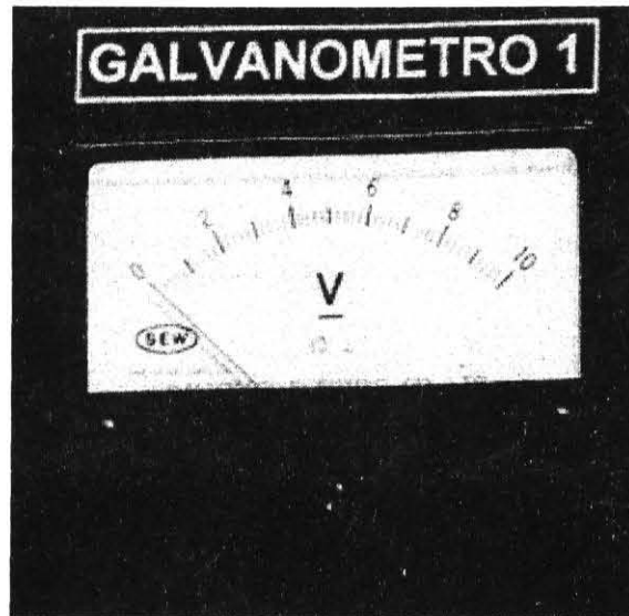
Figura 2.31 Vista de uno de los galvanómetros del tablero
