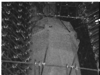
Foto 1. Columna reforzada por medio de una camisa o férula de concreto armado, la cual está en proceso de retiro (véase foto 2). OMGT, septiembre de 2008
