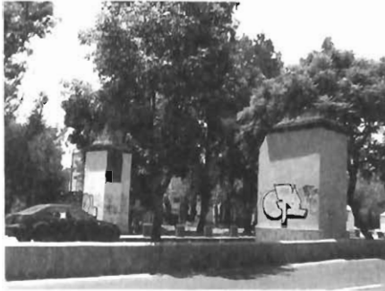
Foto 1. Basamento de puerta de la rotonda con exedras, puertas y vasos ornamentales (Olga Margarita Gutiérrez Trapero, 28 de enero de 2010)
