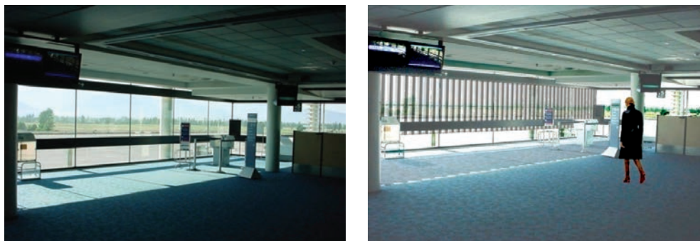
Figura 36 y 37. Antes y después de la instalación del control solar en pabellón de salidas.
