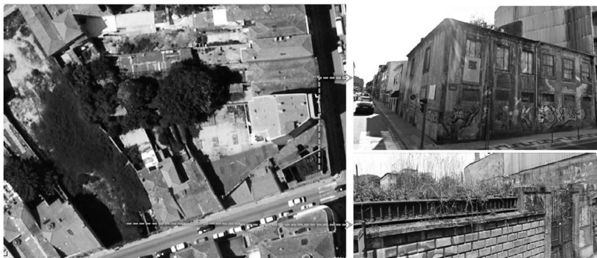
Figura 14. Ejemplos de invasión por vegetación en edificios abandonados (Google Maps, 2011).
