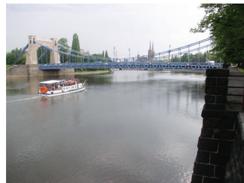
Figura 21. Río Oder y puente Grunwaldzki. Foto: L. Maluga.
