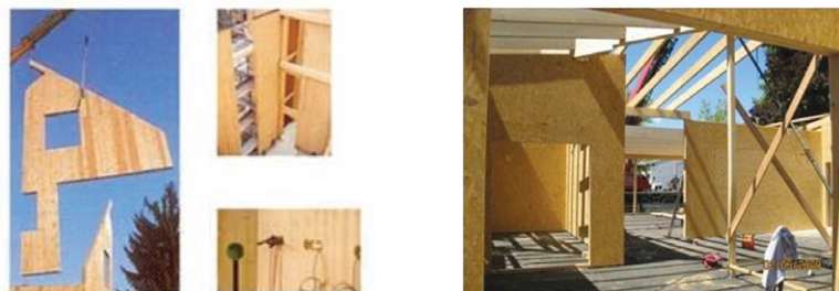
Figura 13b. Marcos de madera prefabricados. Fuente: Revista “Holzbau aktuell”, Düsseldorf/Berlín, Alemania, 03/ 2010.
