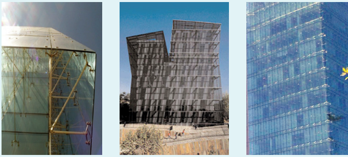
Figura 8. Fachadas en Santiago con abuso de la piel ventilada acristalada, la cual no ha mostrado beneficios.
