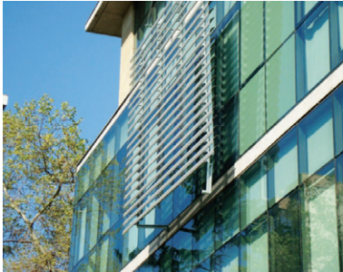
Figura 15. Captación y/o control solar. Protección solar exterior, la más eficiente.
