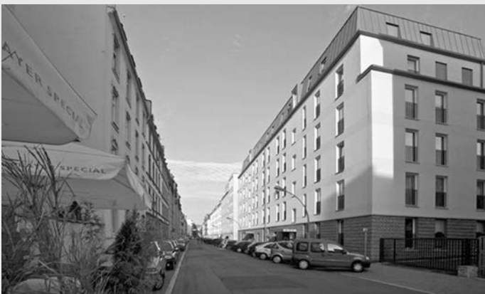
Figura 13. Terminal de tranvía preexistente en Bornheim, Frankfurt/Main ( www.as-p.de ).
